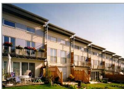
Es handelt sich um die erste deutsche Passivhaus-Siedlung (Baujahr 1997, Bauträger Rasch&Partner) mit 22 Häusern. In Abbildung 3 sind die Wärmezählermesswerte der Heizperiode 1998/99 dokumentiert. Der Mittelwert ergibt **13,4 kWh/(m<sup>2</sup>a)**. Damit liegt der Verbrauch in der Passivhaus-Siedlung um 80% unter dem der Niedrigenergie-Siedlung Niedernhausen.
