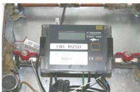
$Q_H$  ist der gemessene **Heiz(nutz)wärmeverbrauch**. Gemessen wurde bei fast allen Messprojekten direkt an der Wärmeübergabestelle der Heizwärmeverteilung (in der Regel mit Wärmehäufigkeitszählern; genaueres dazu ist in den jeweils zitierten wissenschaftlichen Berichten beschrieben). Diese Messung erfasst
