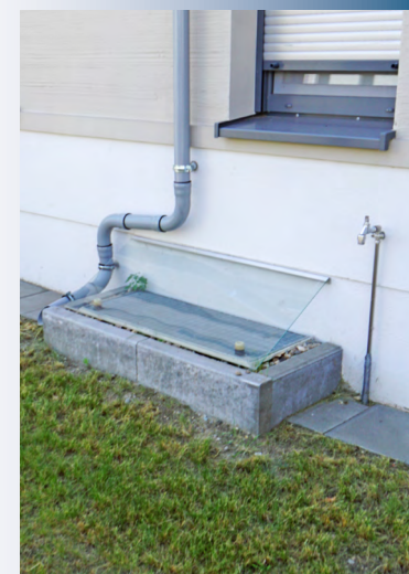
Überflutungsschutz vor Kellerfenster
