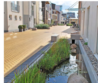
Regenwasserelemente am Gebäude
