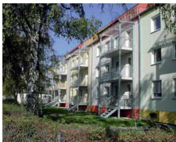
Die Sanierung der Altbauten in der Tevesstraße in der Friedrich-Ebert-Siedlung aus den 50er Jahren wurde gefördert durch das Land Hessen und das Bundes-Förderprogramm „Niedrigenergiehaus im Bestand“. Mit Passivhaus-Elementen liegt der Energiekennwert bei 20 kWh pro qm im Jahr.
