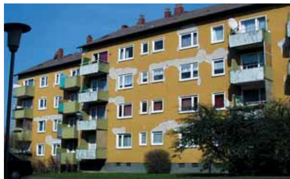
Die Karl-Kirchner-Siedlung vor und nach der Modernisierung
