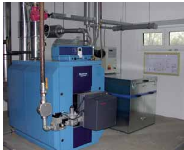
In der Karl-Kirchner-Siedlung steht neben dem Heizkessel das BHKW-Modul.
