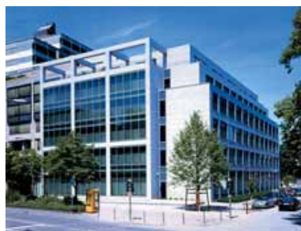
Energiesparendes Bürogebäude der KfW
