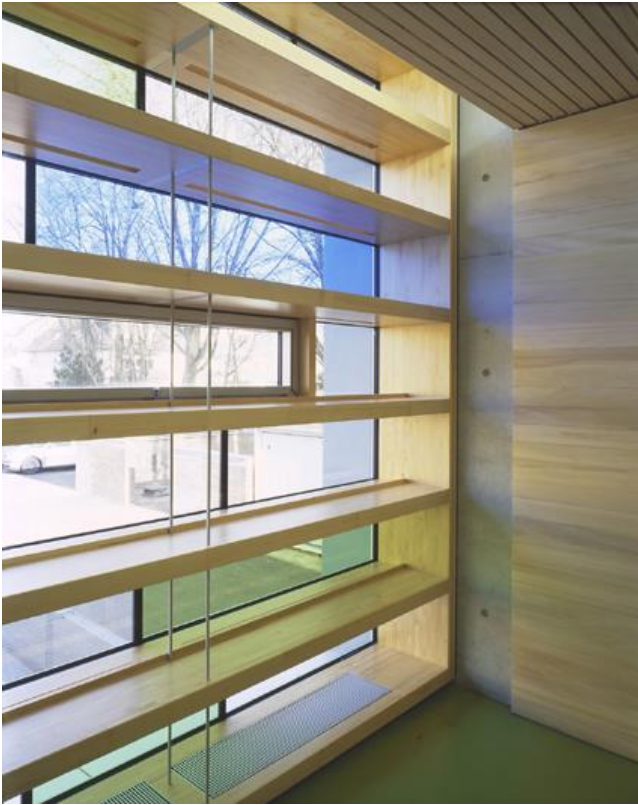
Abb. 25 Die kombinierte Bücherregal-Glas-Fassade aus Holz
