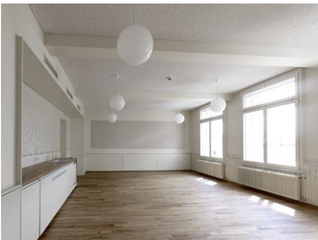
Abb.22 Innenraum des sanierten Altbaus von 1915 mit Echtholzparkett und Lehmputz
