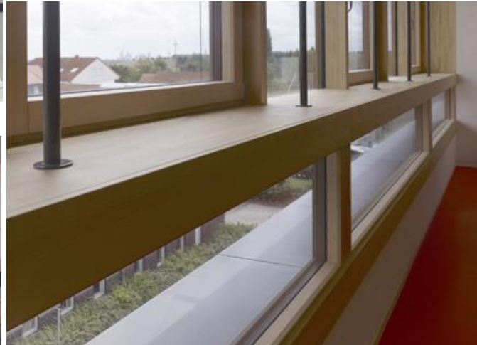
Abb.6 Das „Panoramafenster“ im Detail: Der obere Bereich wird durch den außenliegenden Raffstore, der untere Bereich durch die Tieflage verschattet. Das untere Fenster bleibt also im Sommer frei für die Blickbeziehung zum Außenraum.
