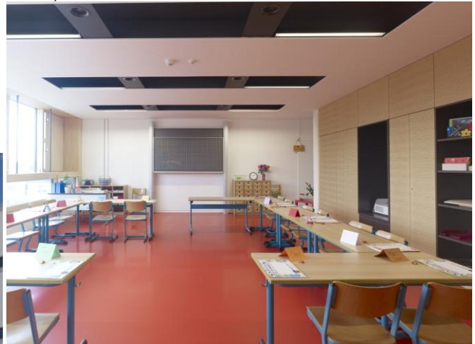
Abb.5 Blick in einen Klassenraum mit maximaler Verglasung zur Sonnenseite, Nachtlüftungsklappen und „Panoramafenster“ für Kinder
