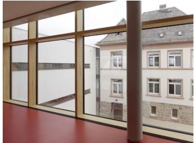
Abb.19 Erhalt und Einbindung des alten Schulhauses von 1915
