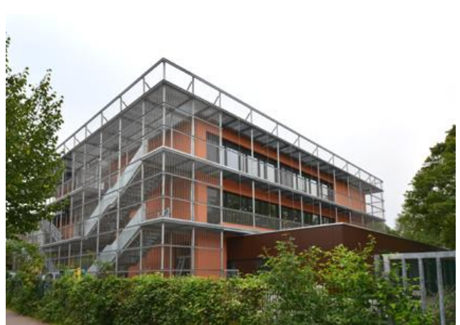
Abb.11 Geschlossene Nordfassade minimiert Energieverluste
