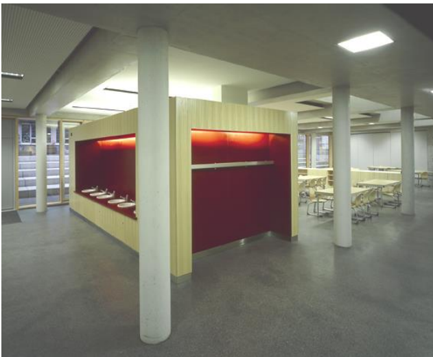
Abb.18 Mensa Münzenbergerschule in Sichtbetonkonstruktion mit möbelartigen Einbauten
