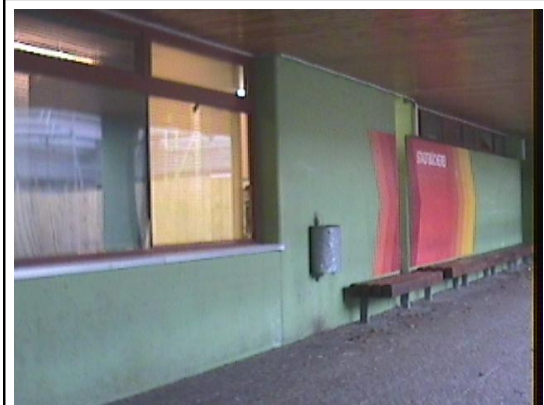
Bauteil: Westfassade, Bauteil B Bemerkungen: Fassadedämmung unzureichend, Erhebliche Wärmbrücken, undichte Fenster.
