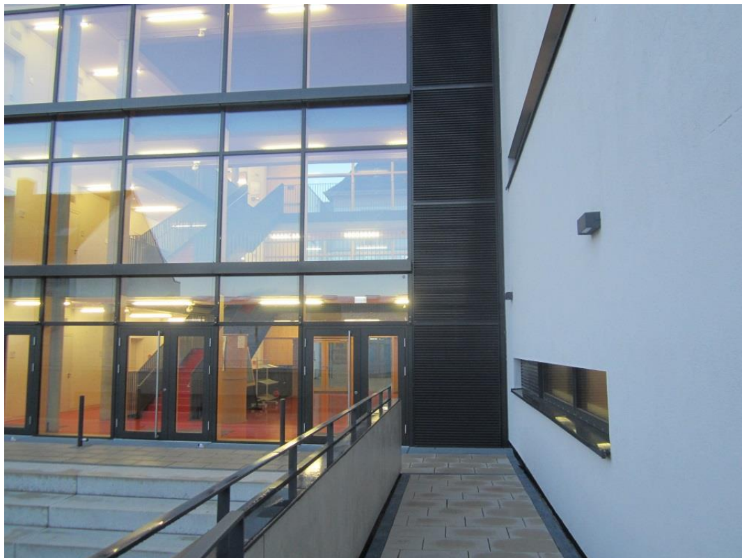
Abbildung 3: Glasfassade des Atriums, Alu-Lamellenverblendung, rechts Wand mit WDVS
