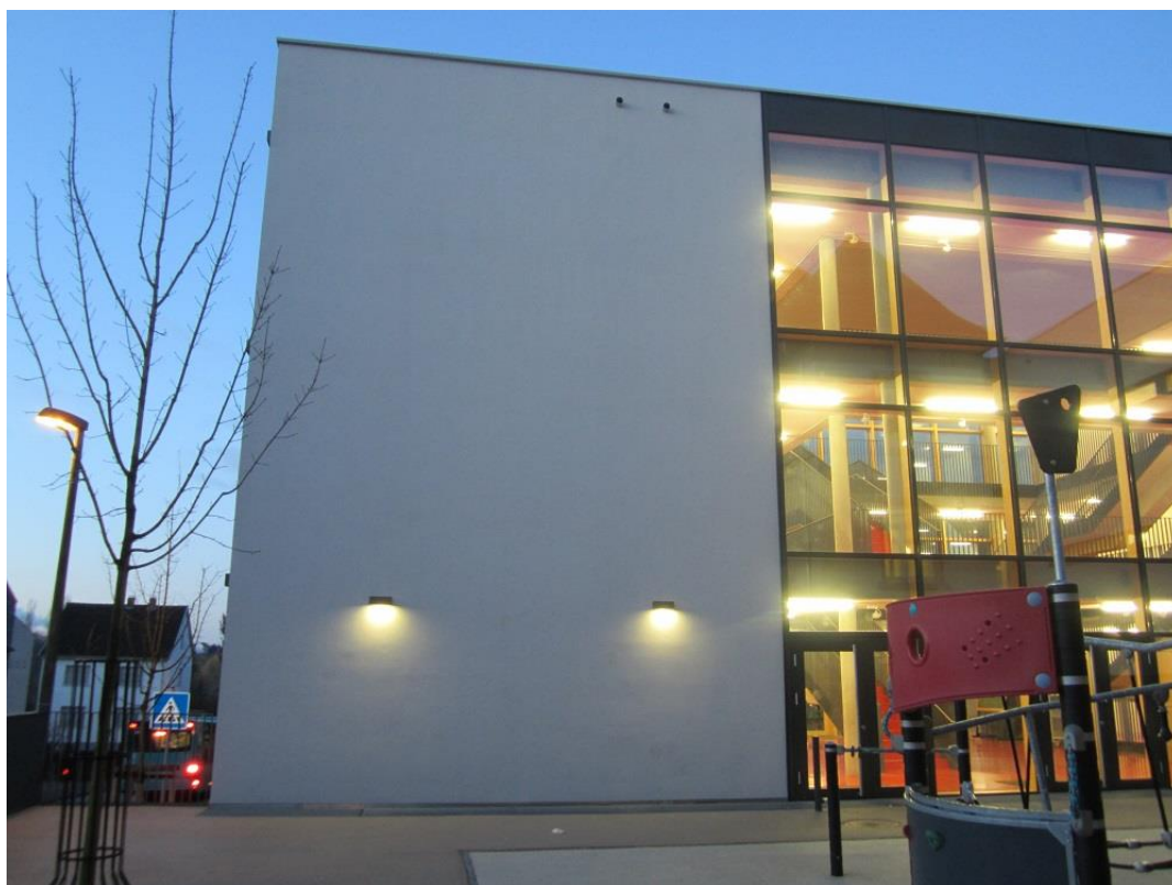
Abbildung 2: Wandscheibe mit WDVS mit Glasfassade des Atriums
