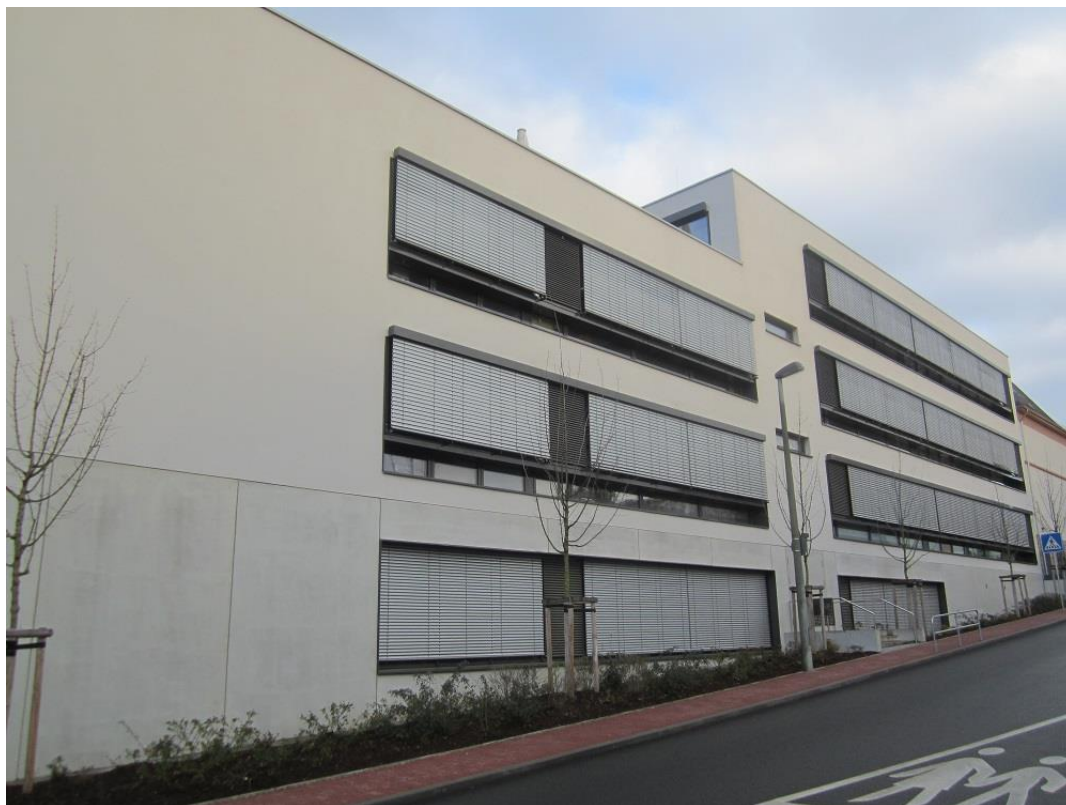
Abbildung 4: Fassade zur „An der Grünhohl“ hin mit Betonfassade im unteren Bereich, im oberen Bereich WDV
