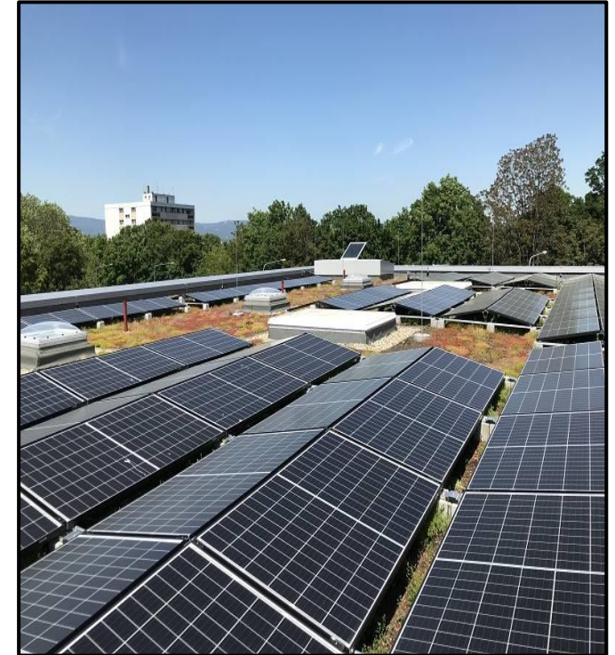
Anlagenfoto (Quelle: Stadt Frankfurt a.M.)
