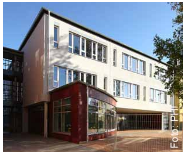
Abbildung 28: Schmale Öffnungsflügel, die nur unwesentlich über die innere Fensterleibung hinausragen Architektur: BLFP, Friedberg / Haustechnik: Neuplan, Gießen (Quelle: PHI [AkkP 33])
