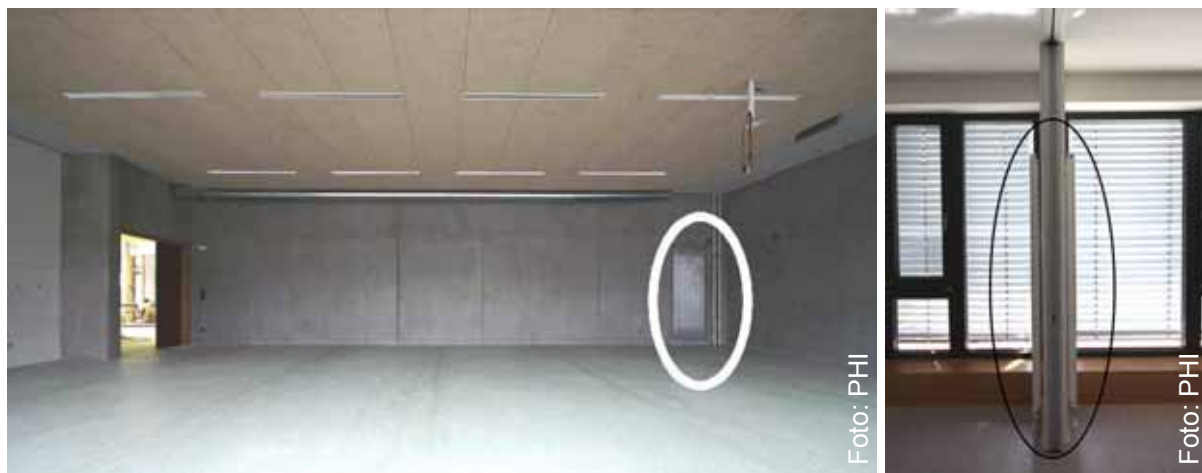
Abbildung 86: Beheizung über Heizkörper im Schul-Pavillon Walldorf (Foto links). Architektur: IB W. Herrmann, Walldorf / Haustechnik: Gadow + Graeske, Walldorf. Anordnung der Heizkörper an angrenzender Innenwand mit kompakten Verteilnetzen (Foto rechts) in einer Passivhaus Kindertagesstätte (Ginsterhöhe) in Frankfurt. Architektur: ppplanung architekten, Wiesbaden / Haustechnik: Planungsbüro Donath, Neu-Isenburg
