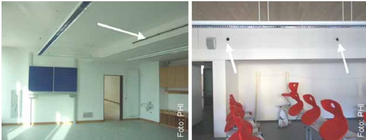
Abbildung 69: Schlitzauslässe (Bild links) haben sich gut bewährt. Strahlauslässe (Bild rechts) sollten nicht mit zu hohen Luftgeschwindigkeiten betrieben werden (besser mehrere Auslässe setzen), damit keine Zugerscheinungen entstehen. Passivhaus-Schule Frankfurt (links): Architektur: 4a, Stuttgart / Haustechnik: ICRZ Ing. Cons. Ruth + Zimmermann, Neuenhagen Passivhaus-Schule Alsfeld (rechts): Architektur: BLFP, Friedberg / Haustechnik: Neuplan, Gießen.
