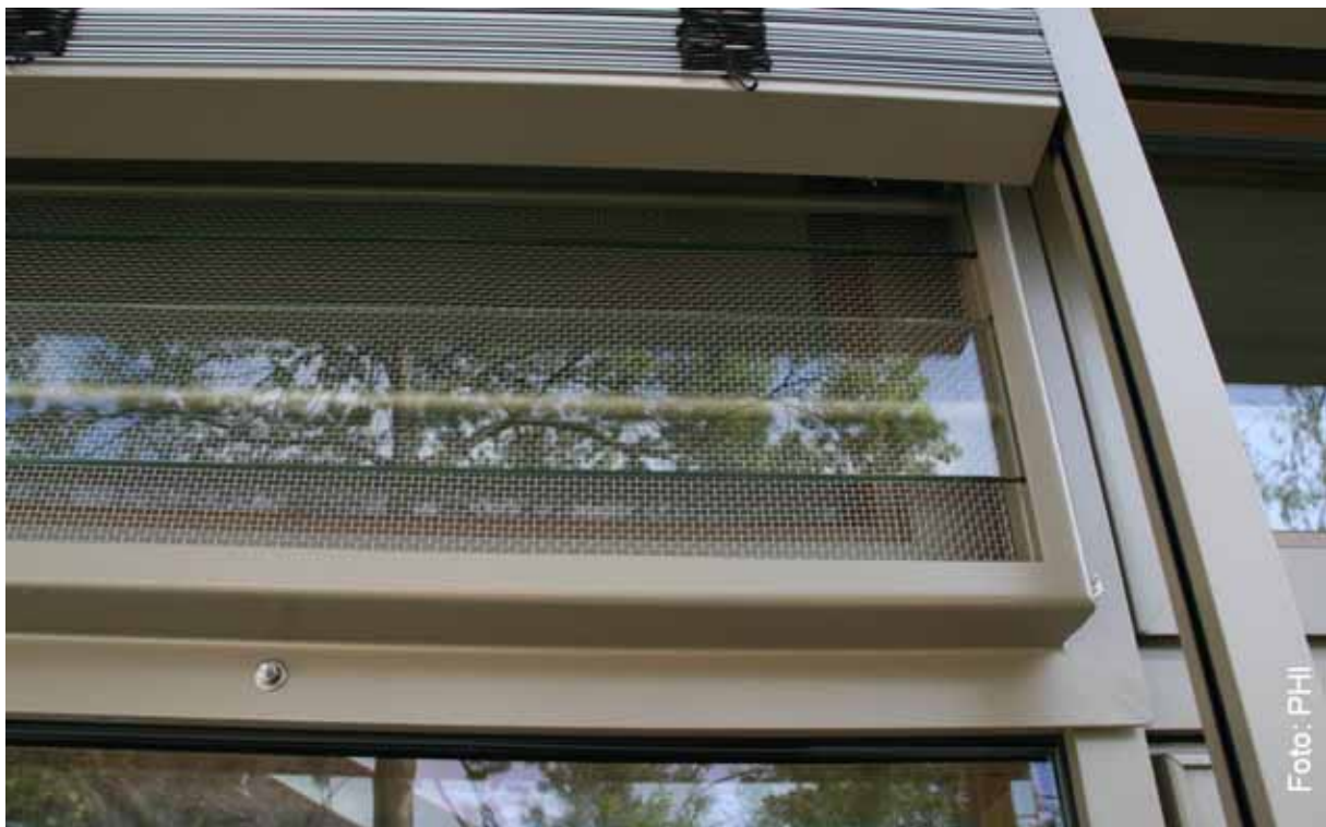
Abbildung 110: Detail einer Lüftungsklappe. Glaslamellen und ein Drahtgewebe stellen den Einbruch- und Insektenschutz sicher. Kindertagesstätte Goldstein (Frankfurt), Architektur: AS&P, Frankfurt
