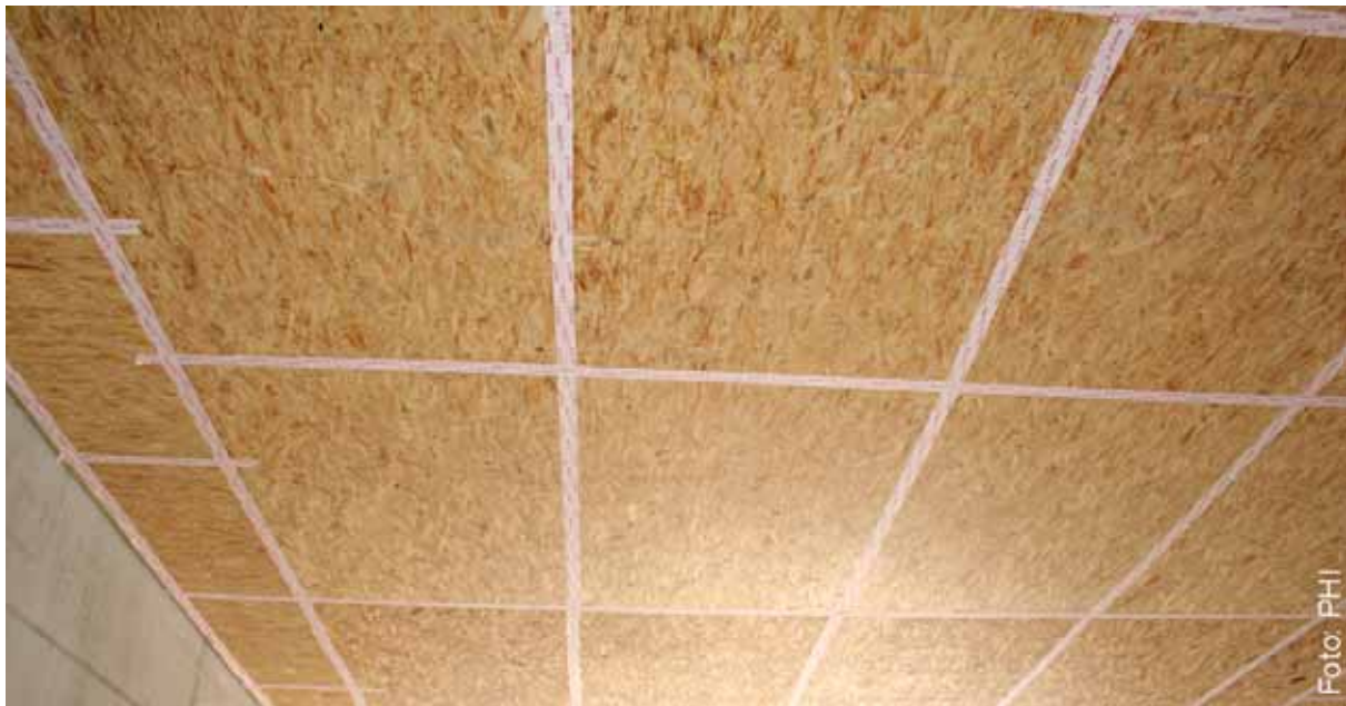
Abbildung 38: Luftdichte Verklebung der Stöße von Holzwerkstoffplatten mit Spezial-Klebeband. Deckenuntersicht des Schul-Pavillon Walldorf. Architektur: IB W. Herrmann, Walldorf.
