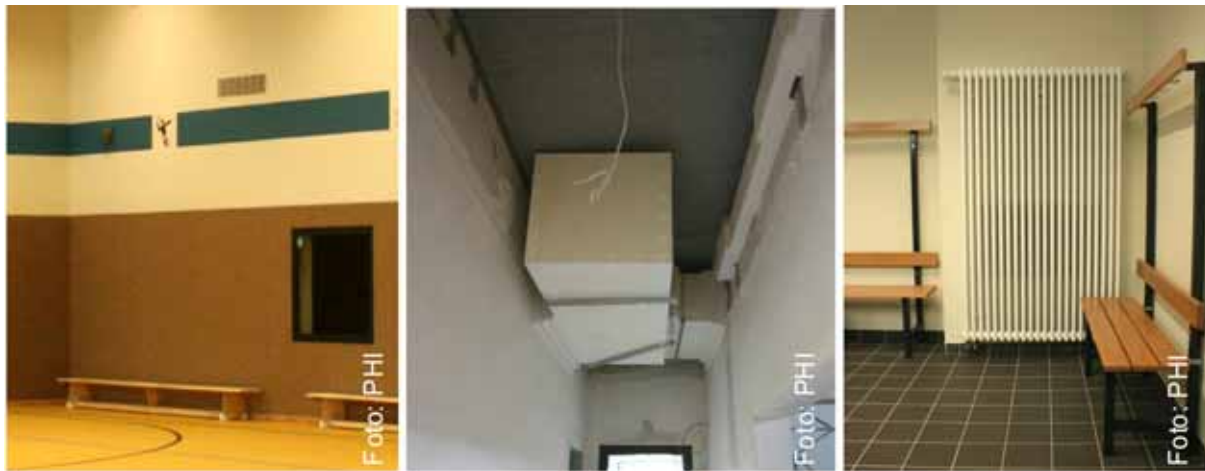
Abbildung 68: Umsetzung der Überströmung bei einer Passivhaus-Sporthalle in Reichelsheim. Die Hallenluft strömt im Bereich des Flurs durch einen brandschutztechnisch ertüchtigten Kanal in die Umkleiden. Ein Heizkörper erwärmt die überströmende Luft in den Umkleiden (Überströmöffnung befindet sich hinter dem Heizkörper).
