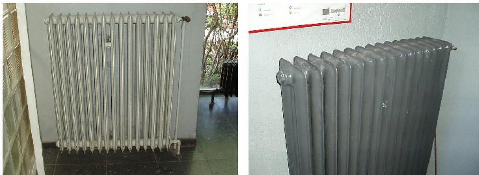
Die statischen Heizkreise versorgen alle Nebenräume über eine Außentemperatur geführte Vorlauftemperaturregelung. Die Heizkörper haben **überwiegend keine Thermostatventile**. Da die meisten Ventile nicht entsprechend fein eingedrosselt sind und nicht hydraulisch genau
