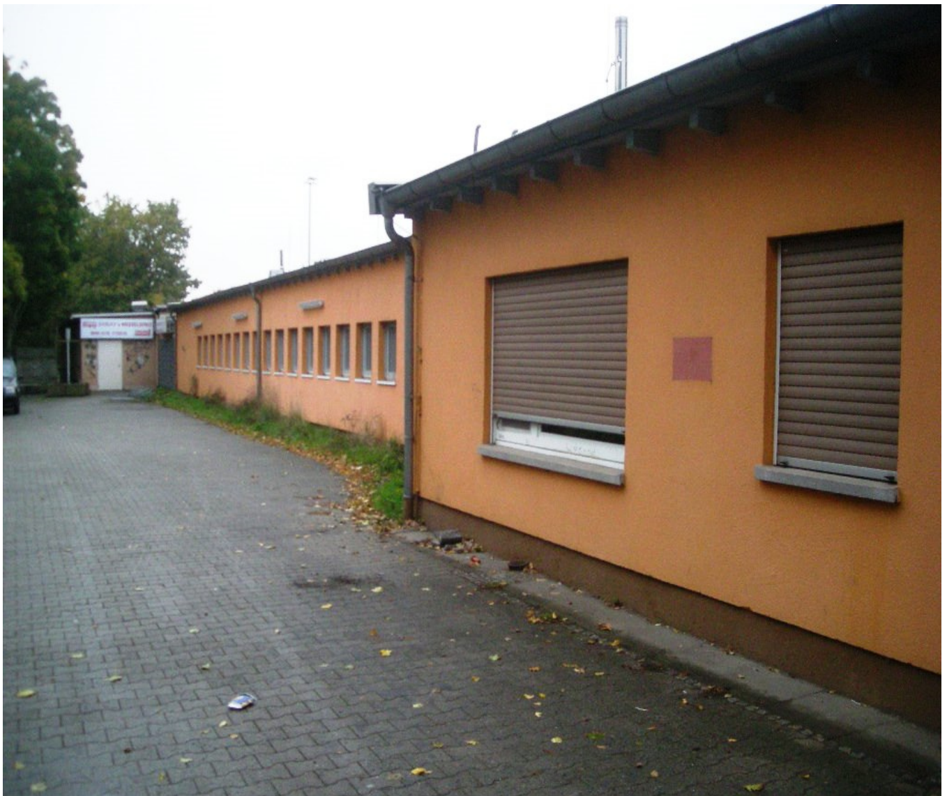
Außenansicht des Umkleidebereiches
