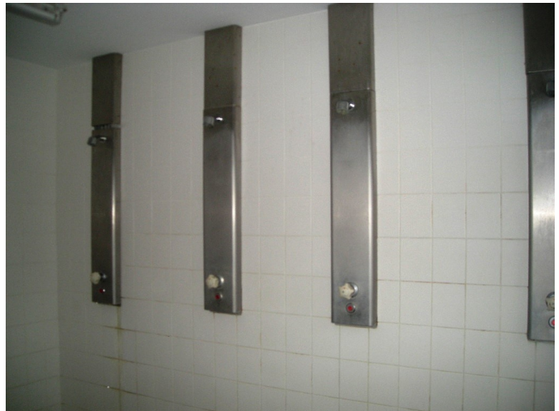
Duschen der Sportanlage
