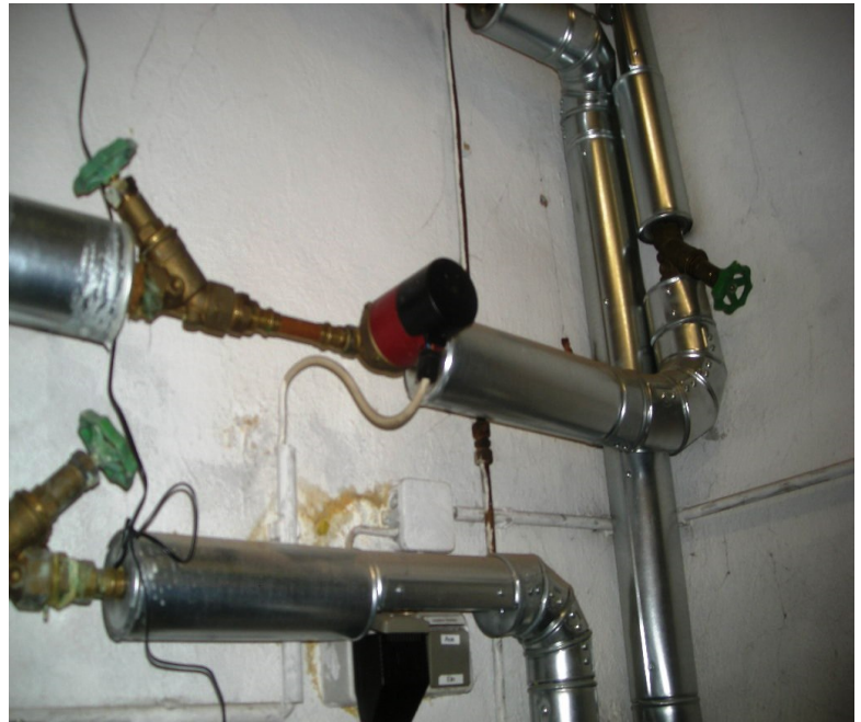
Zirkulationspumpe der Sportanlage
