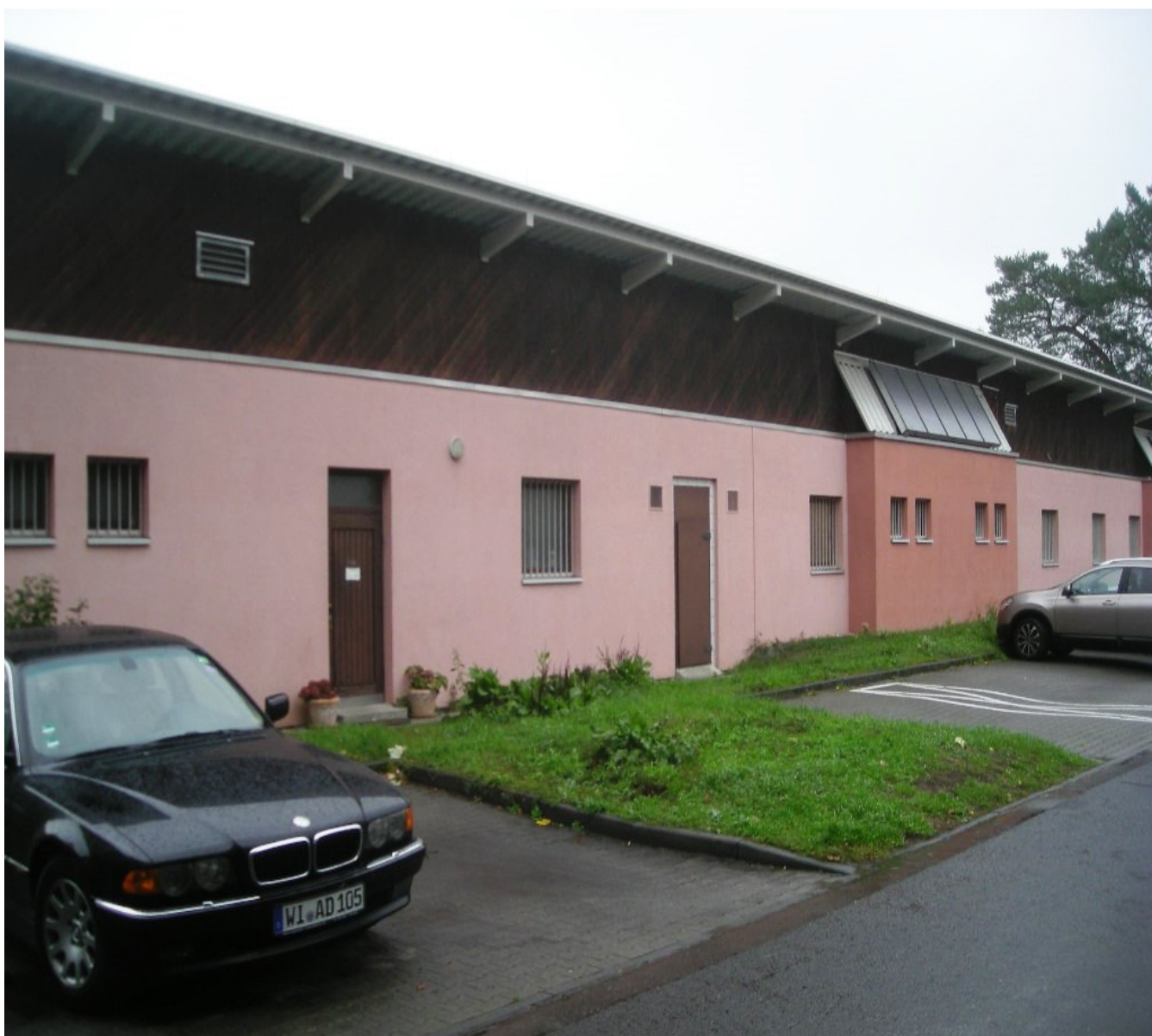
Außenansicht des Umkleidegebäudes
