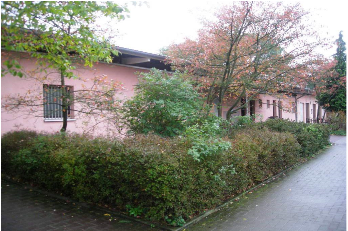
Außenansicht des Umkleidegebäudes
