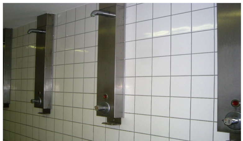
Duschen der Sportanlage
