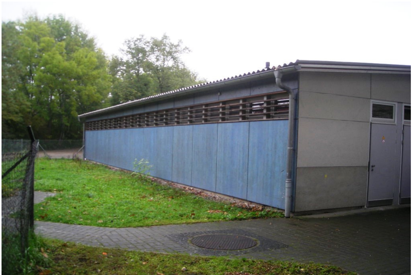
Außenansicht des Umkleidegebäudes
