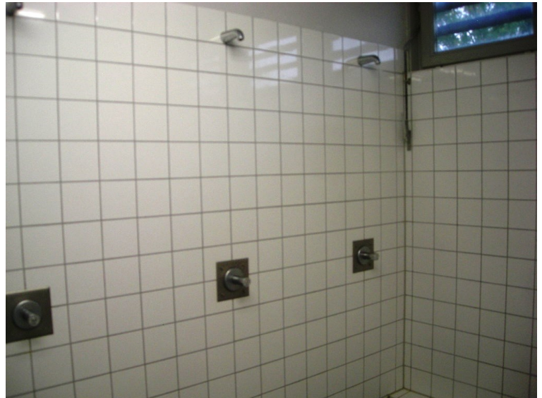
Duschen der Sportanlage
