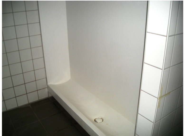
Urinal Rinne der Sportanlage
