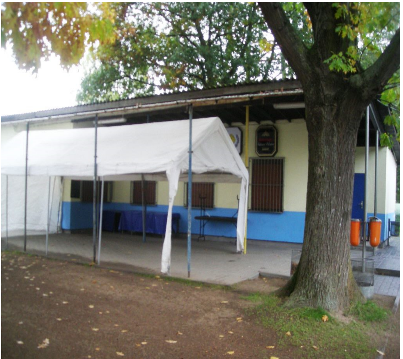
Außenansicht des Umkleidegebäudes
