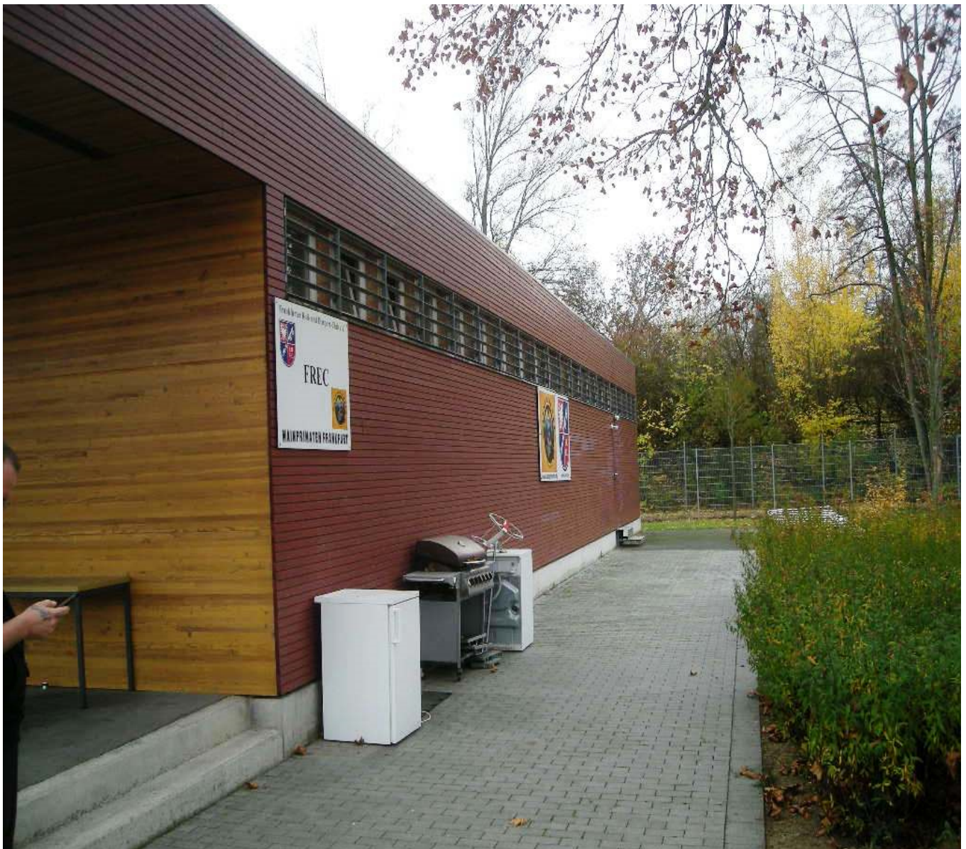
Außenansicht des Umkleidegebäudes
