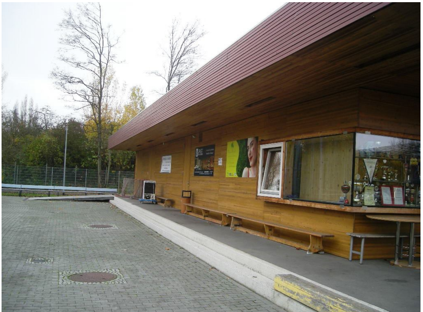
Außenansicht des Umkleidegebäudes
