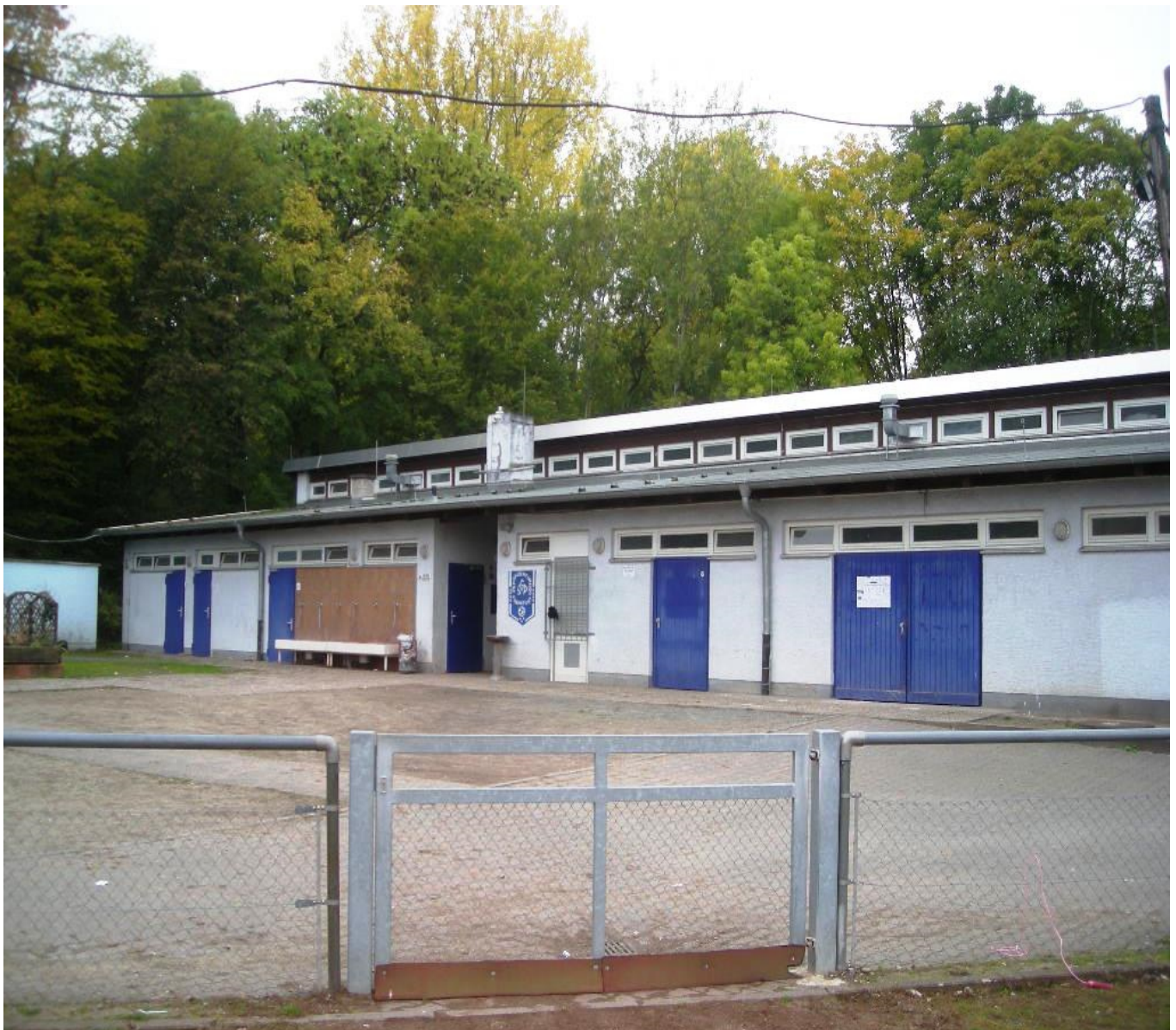
Außenansicht des Umkleidegebäudes
