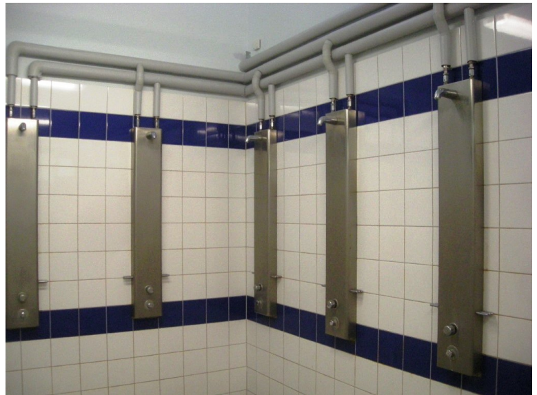
Duschen der Sportanlage
