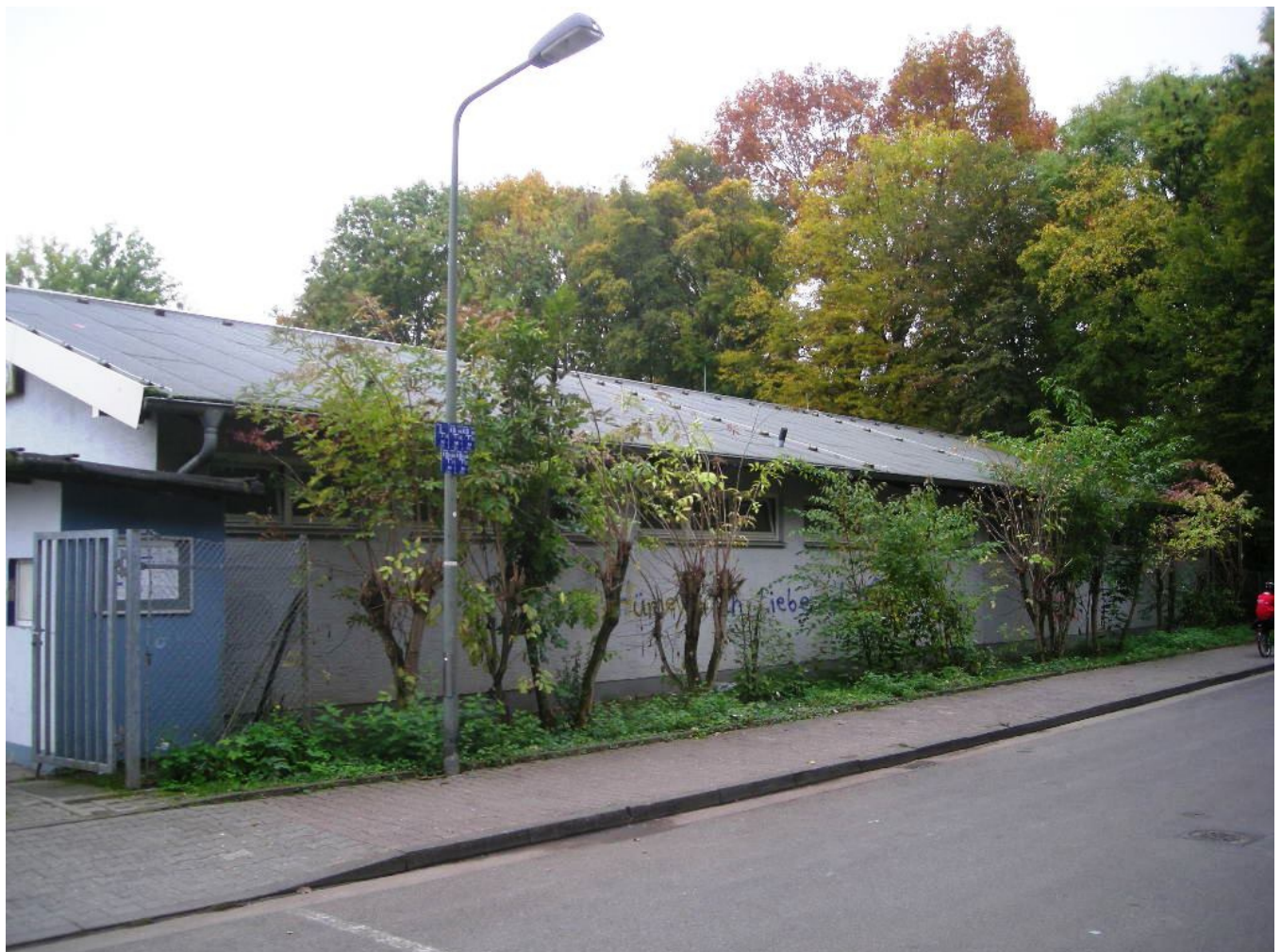
Außenansicht des Umkleidegebäudes
