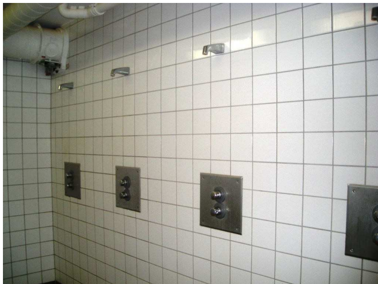
Duschen der Sportanlage
