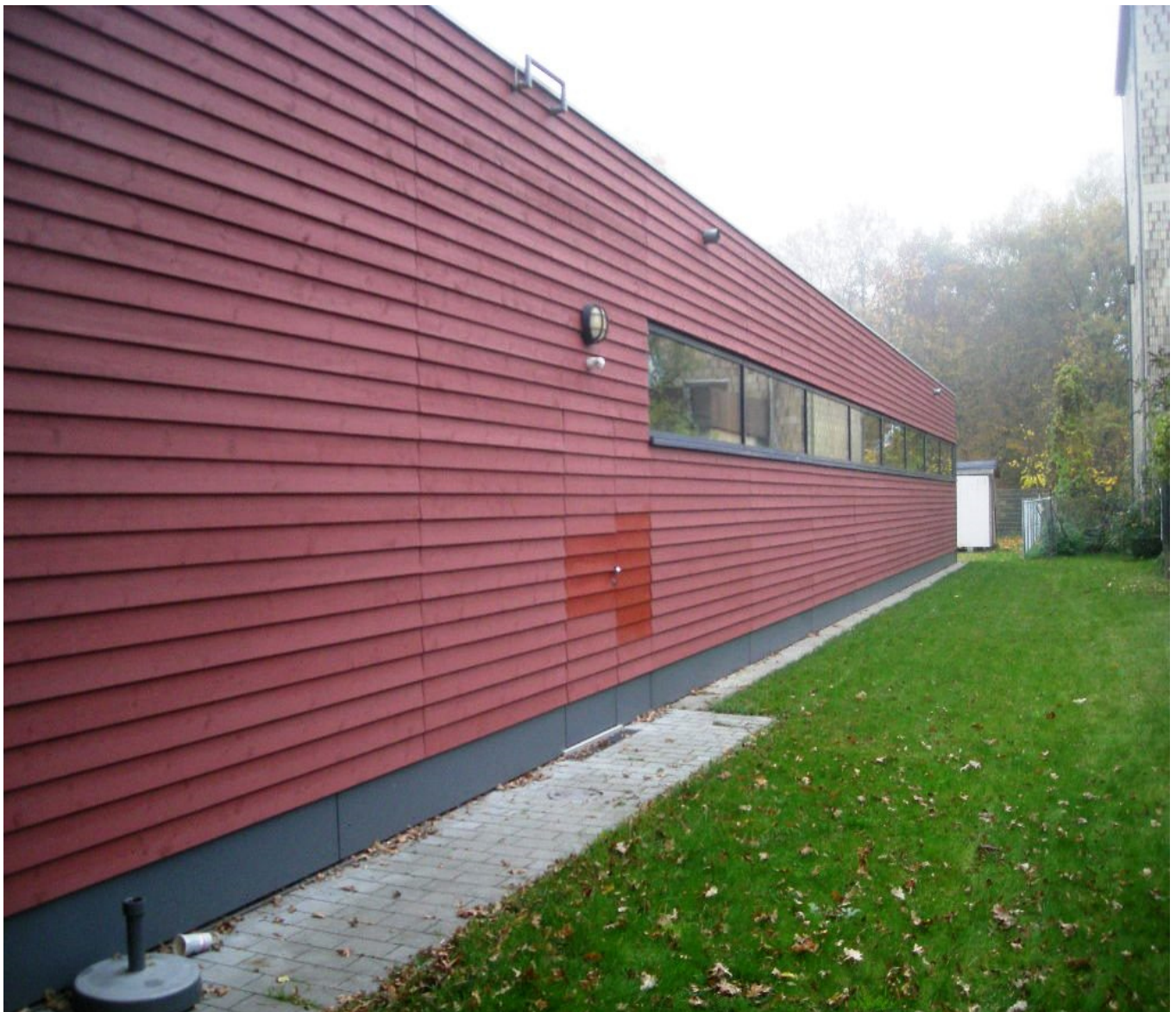
Außenansicht des Umkleidegebäudes
