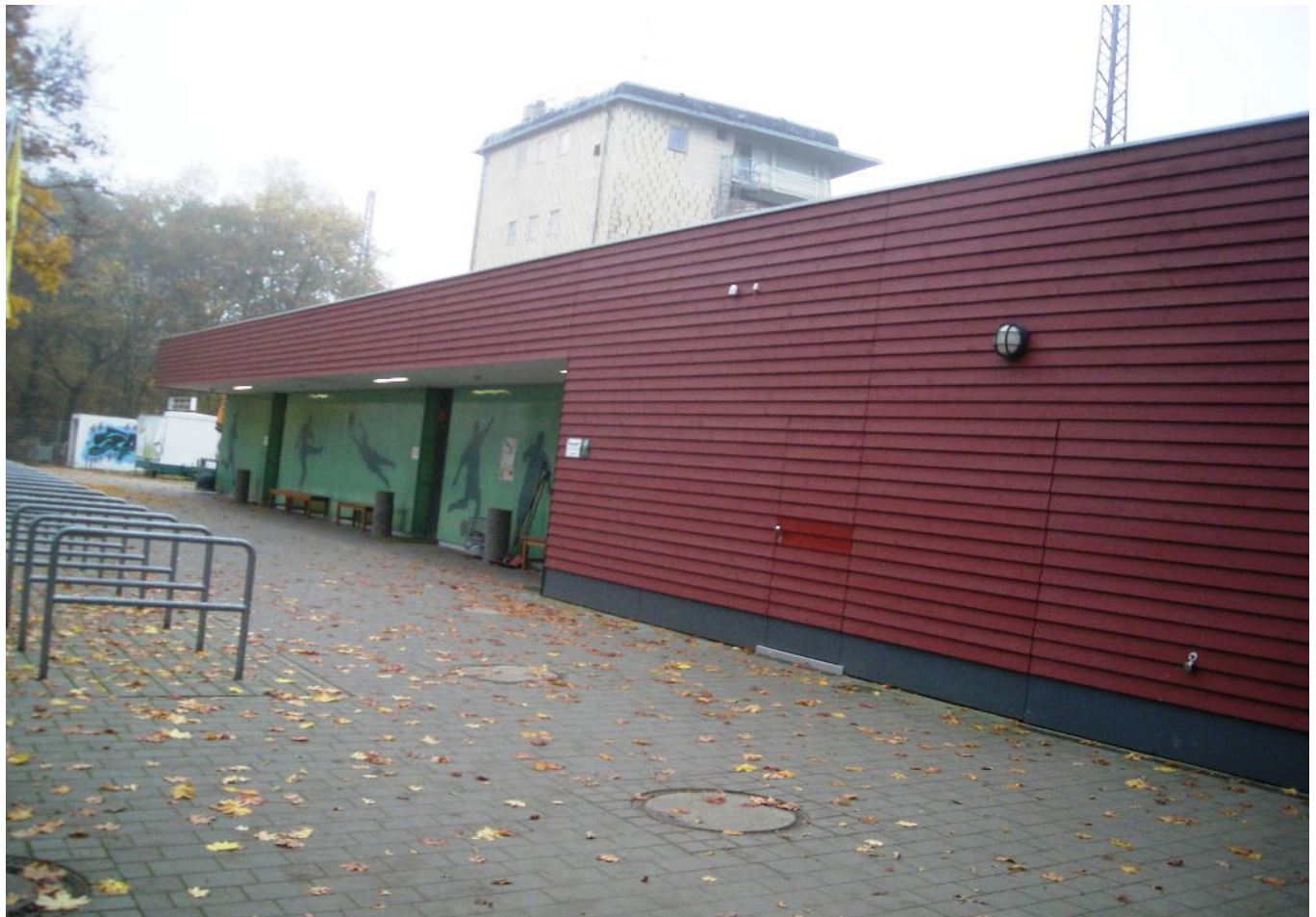
Außenansicht des Umkleidegebäudes
