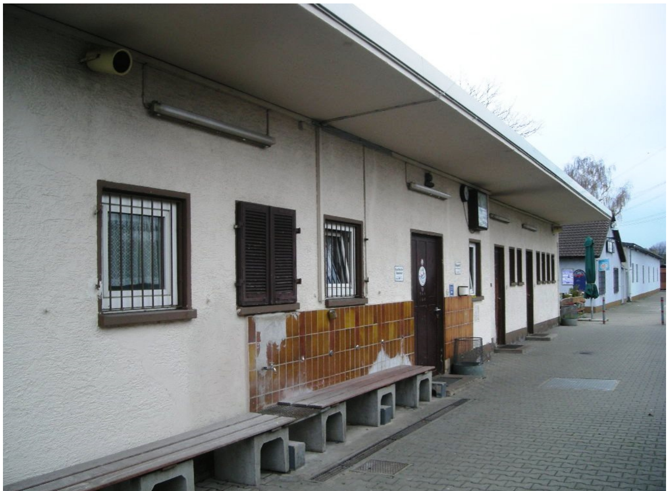
Außenansicht des Umkleidegebäudes
