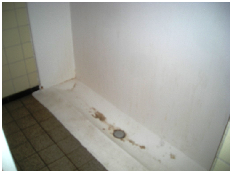
Urinal Rinne der Sportanlage
