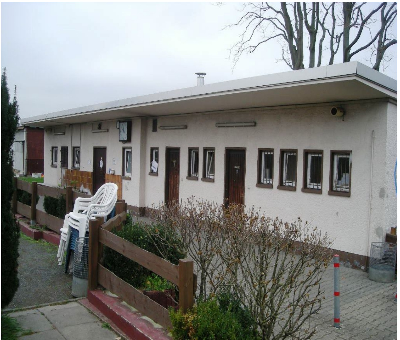
Außenansicht des Umkleidegebäudes
