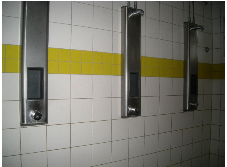
Duschen der Sportanlage
