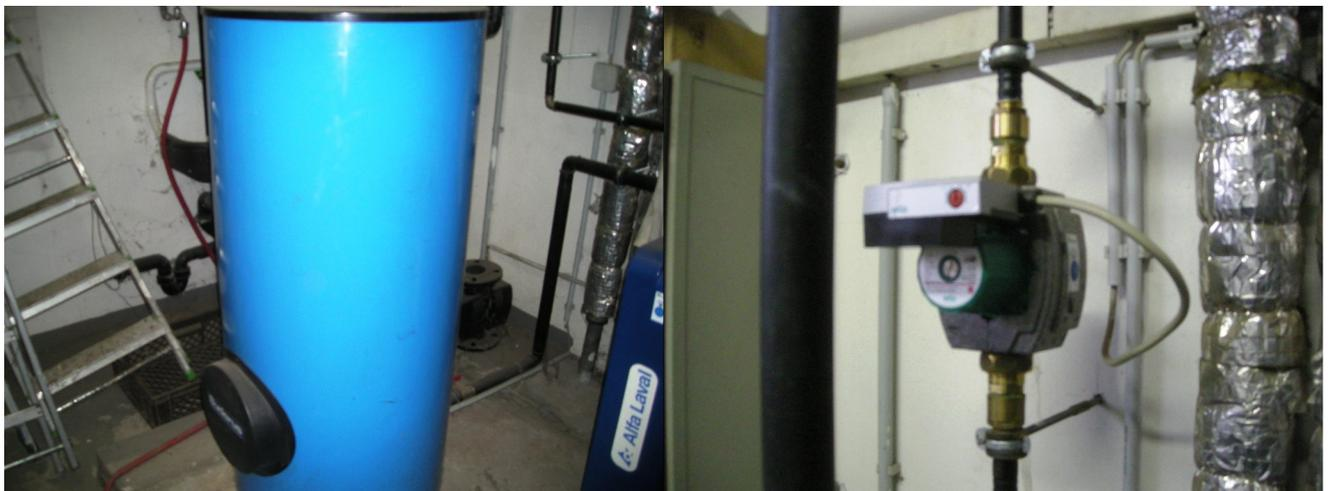
Warmwasserspeicher mit Zirkulationspumpe der Sportanlage
