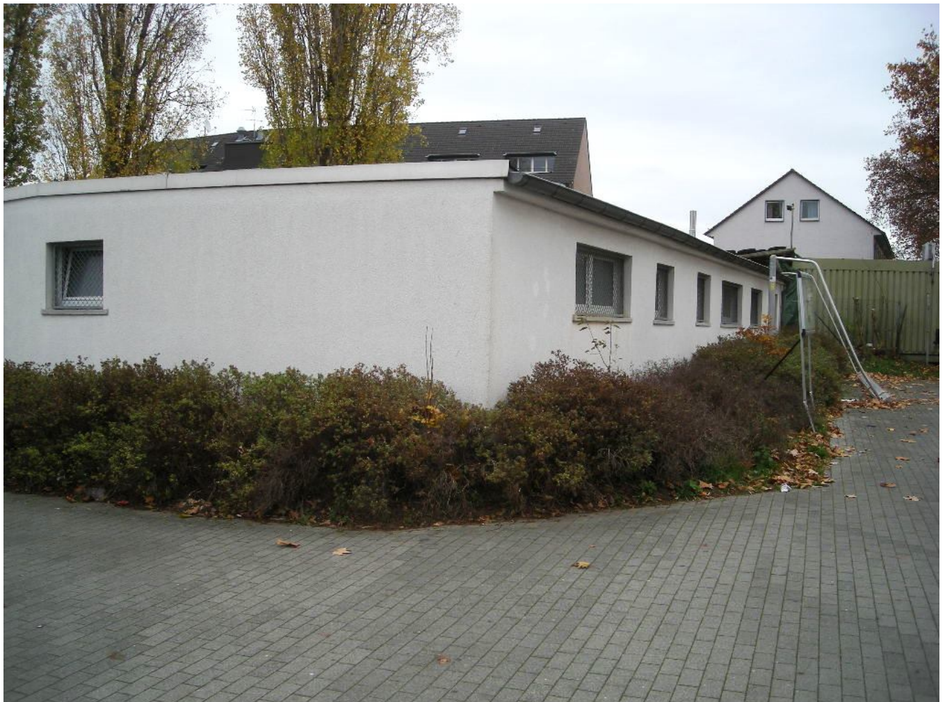
Außenansicht des Umkleidegebäudes
