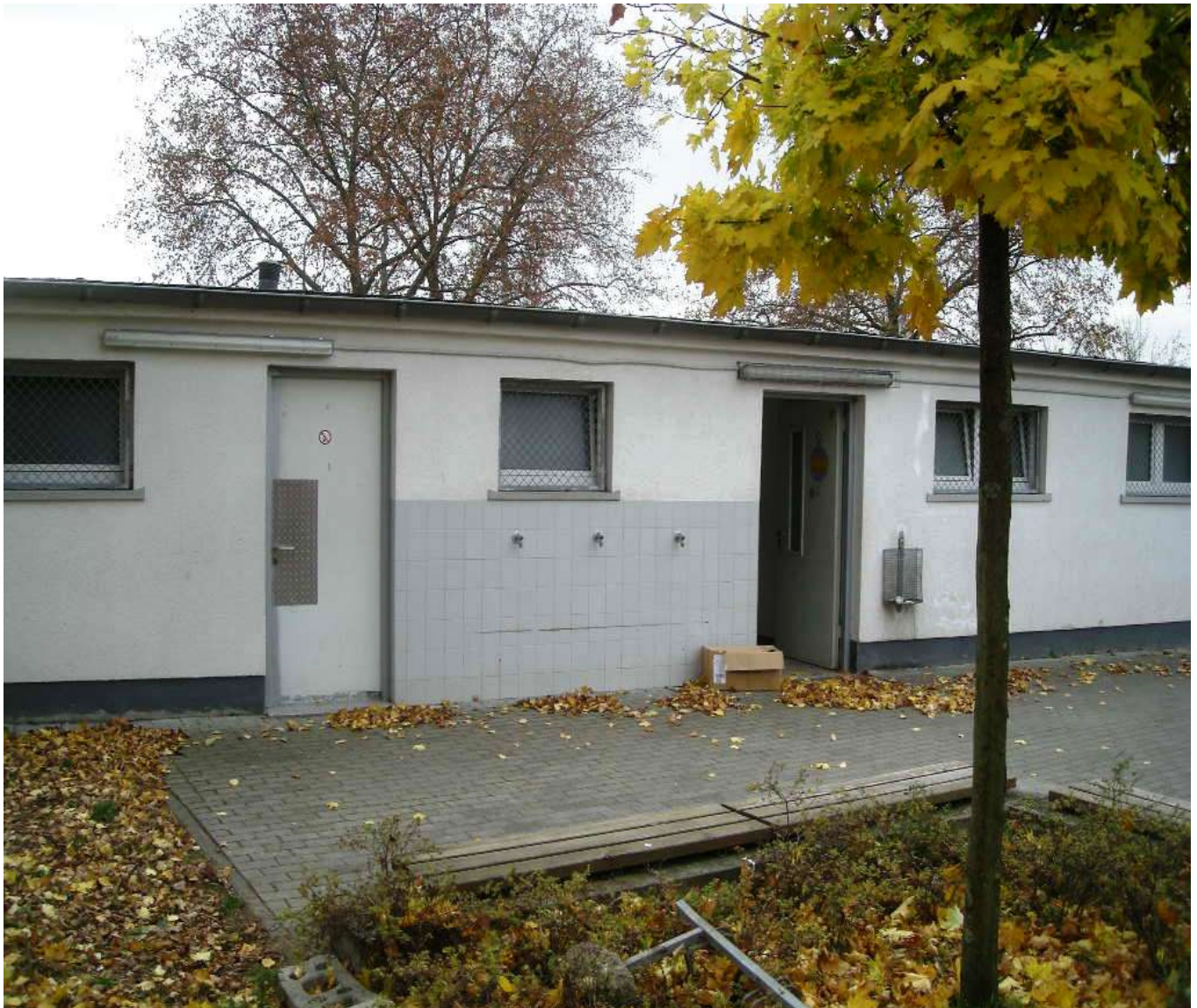
Außenansicht des Umkleidegebäudes
