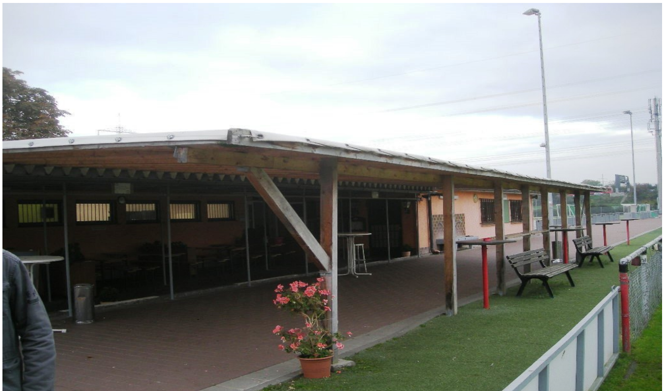
Außenansicht des alten Umkleidegebäudes
