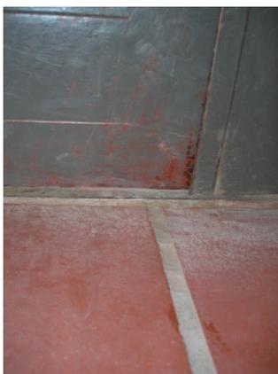
Eingangstür/ alte Stahltür Umkleidegebäude mit fehlender Bodendichtung
