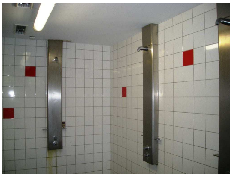
Duschen der Sportanlage
