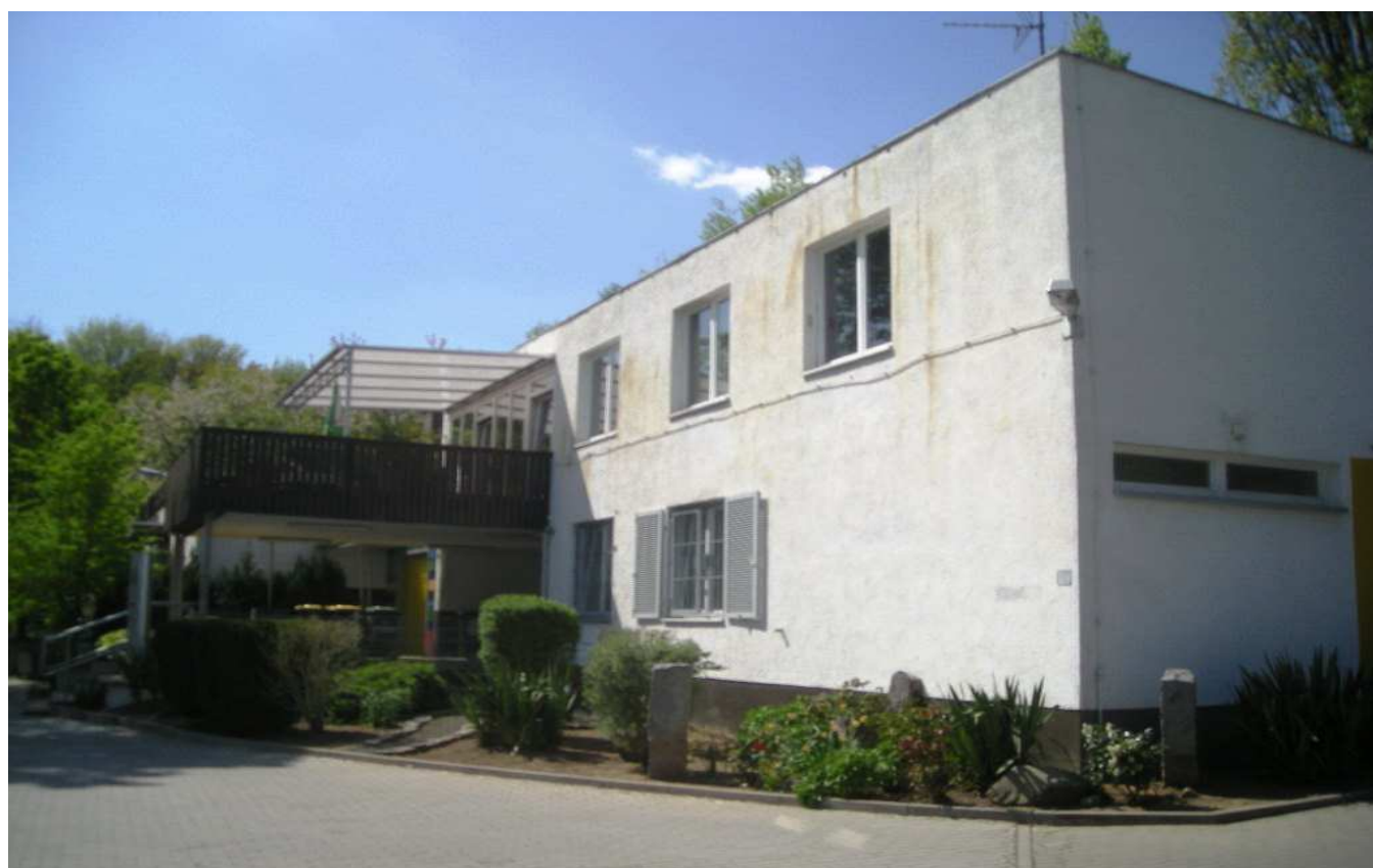
Außenansicht der Gebäudeteile
