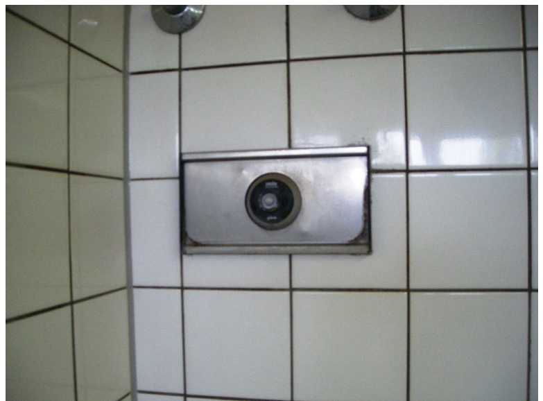
Mischwasserthermostat der Warmwasserbereitstellung
