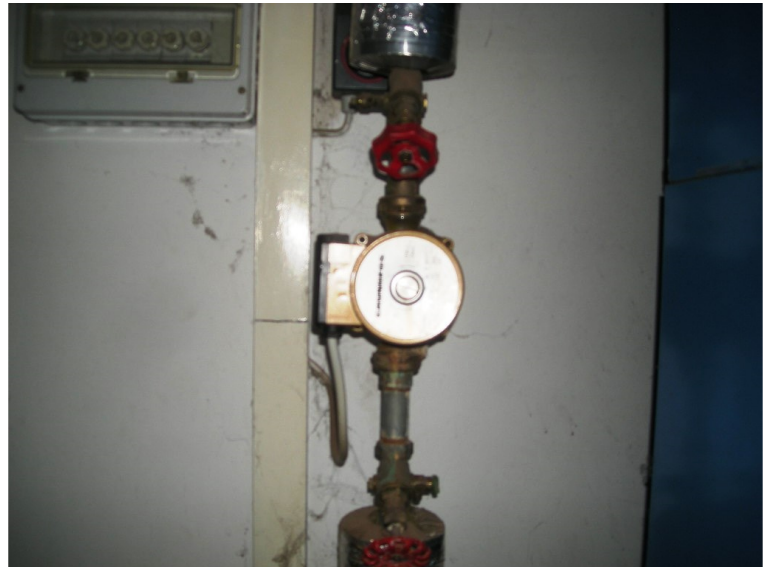
Zirkulationspumpe der Warmwasserbereitstellung
