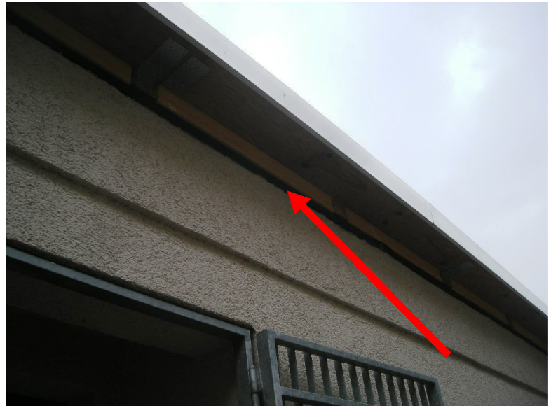
Fuge zwischen den zwei Bauteilen
