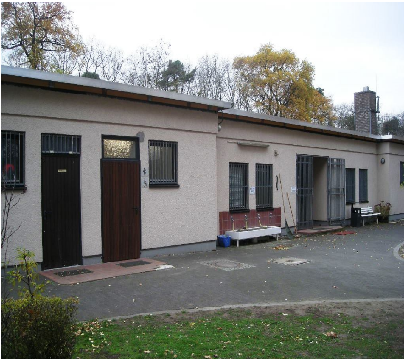
Außenansicht des Umkleidegebäudes
