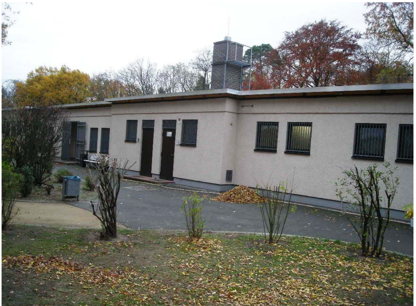
Außenansicht des Umkleidegebäudes
