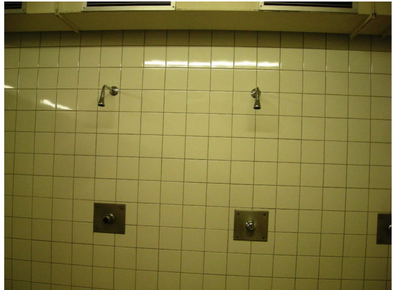
Duschen der Sportanlage
