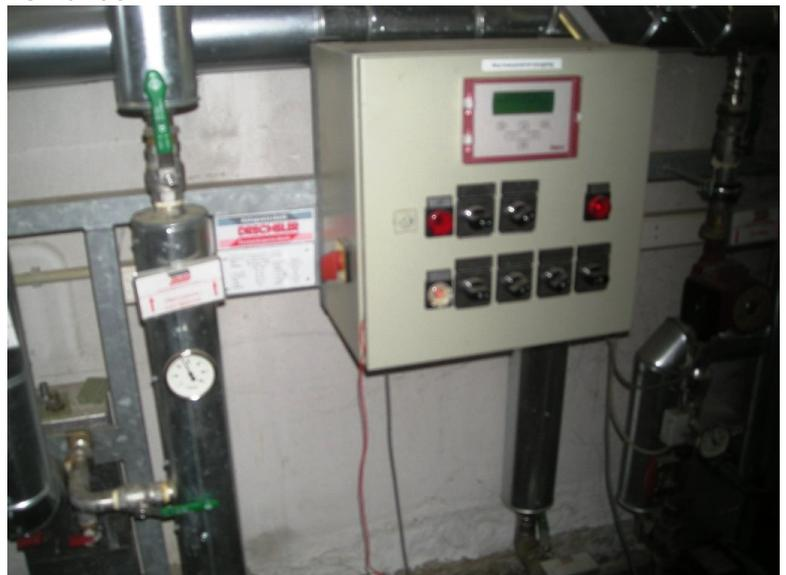
Bis zur Durchgangsarmatur sollte eine Zirkulationsleitung mit permanent durchlaufender Zirkulationspumpe installiert sein (DVGW Arbeitsblätter (aktuellste Fassungen)).
