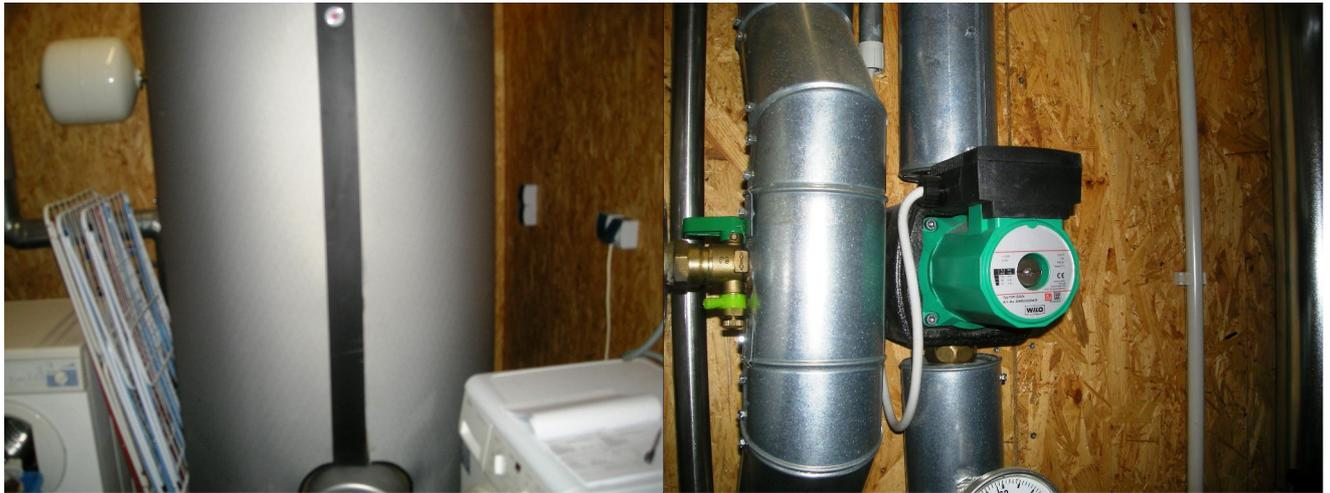
Warmwasserspeicher mit Zirkulationspumpe der Sportanlage
