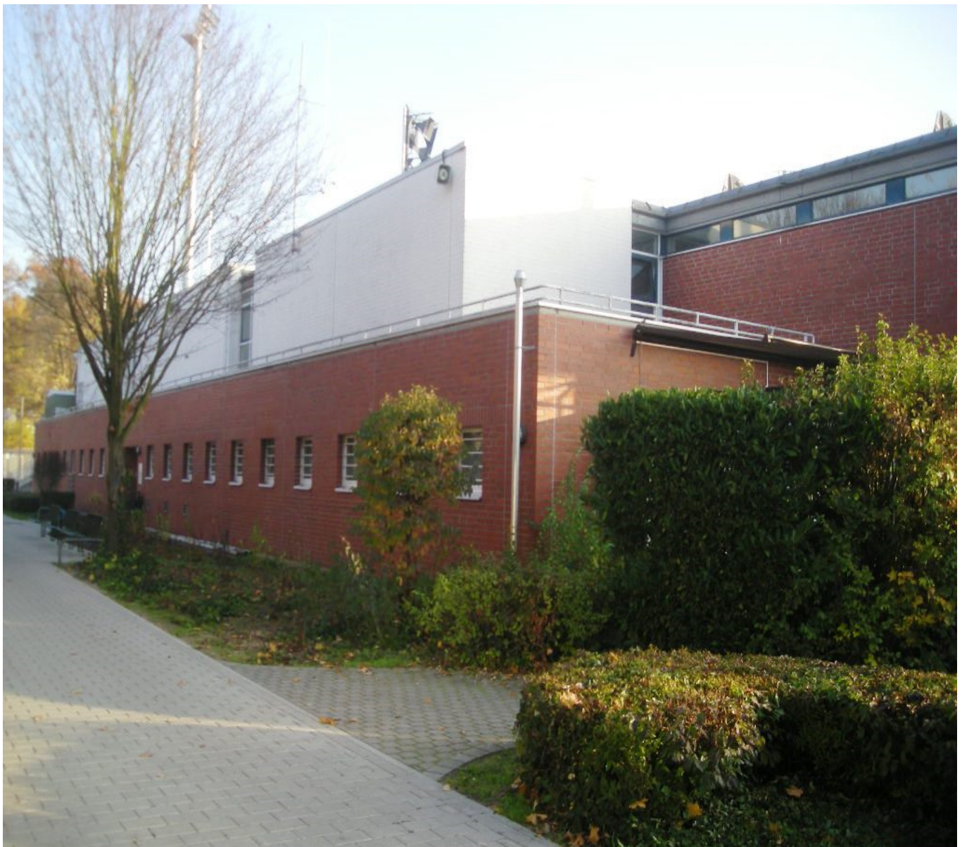
Außenansicht des Umkleidegebäudes
