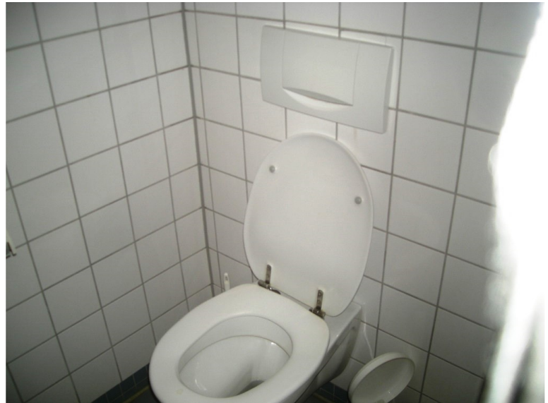
Toilette der Sportanlage
