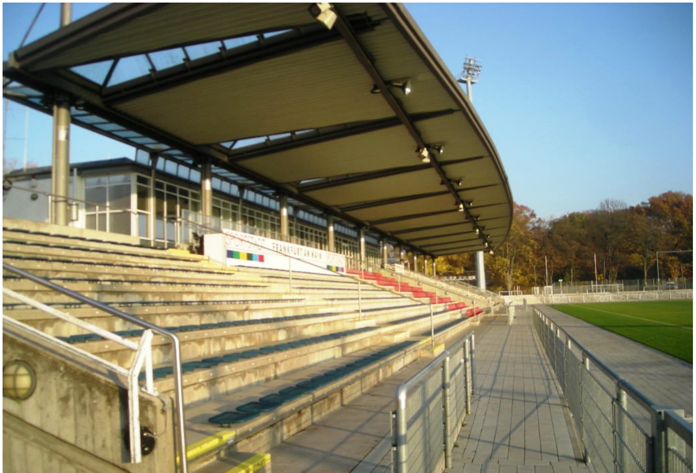
Außenansicht des Tribünengebäudeteils
