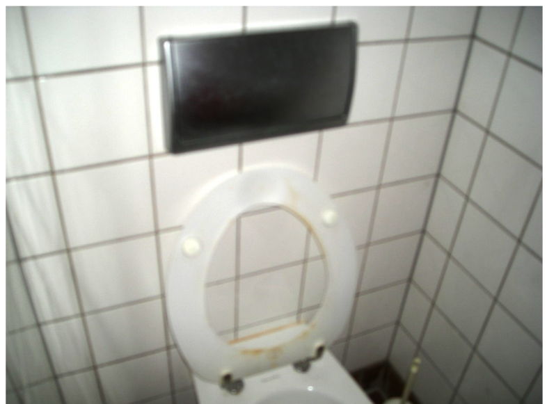
Toilette der Sportanlage
