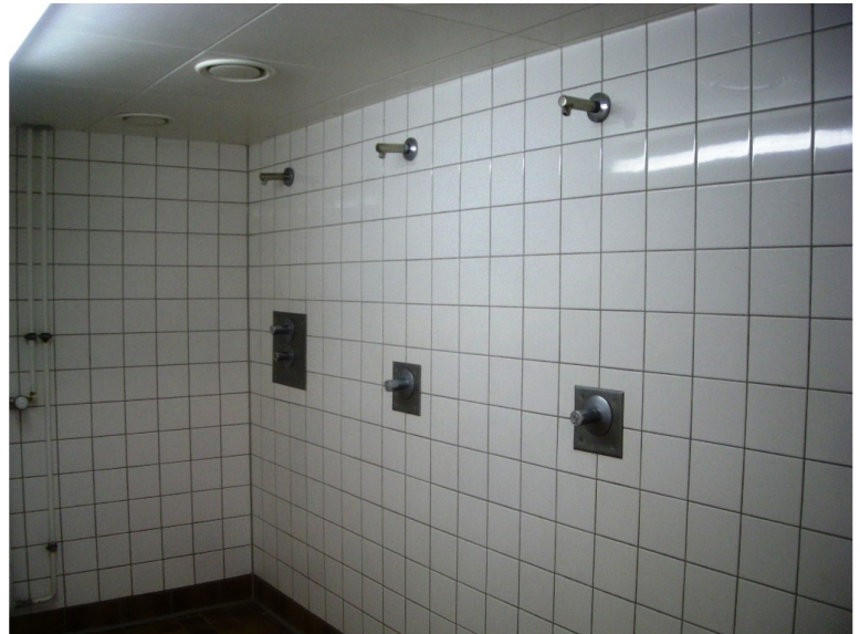
Duschen der Sportanlage
