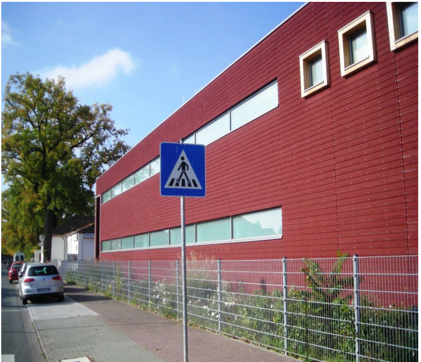
Außenansicht des Umkleidegebäudes
