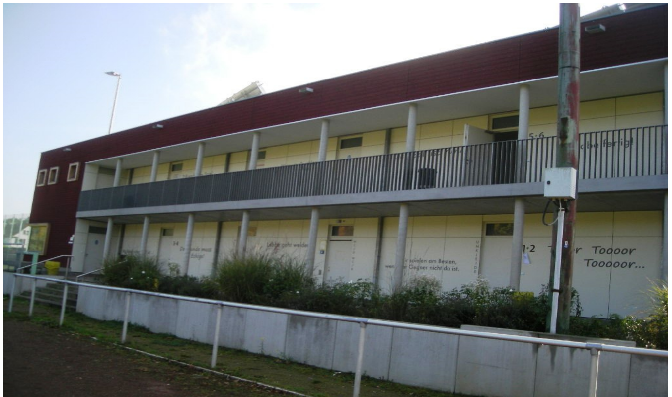
Außenansicht des Umkleidegebäudes
