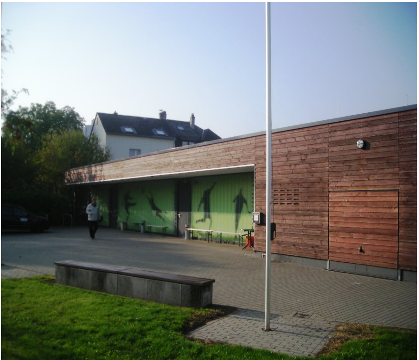
Außenansicht des Umkleidegebäudes
