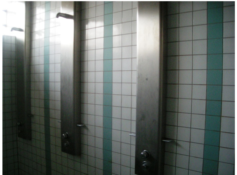
Duschen der Sportanlage
