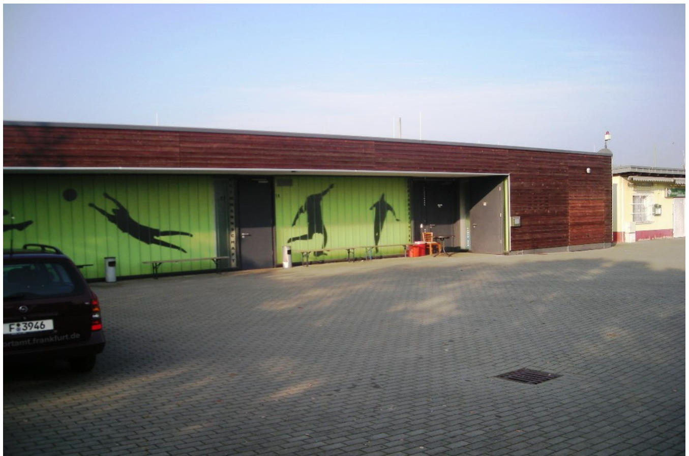
Außenansicht des Umkleidegebäudes
