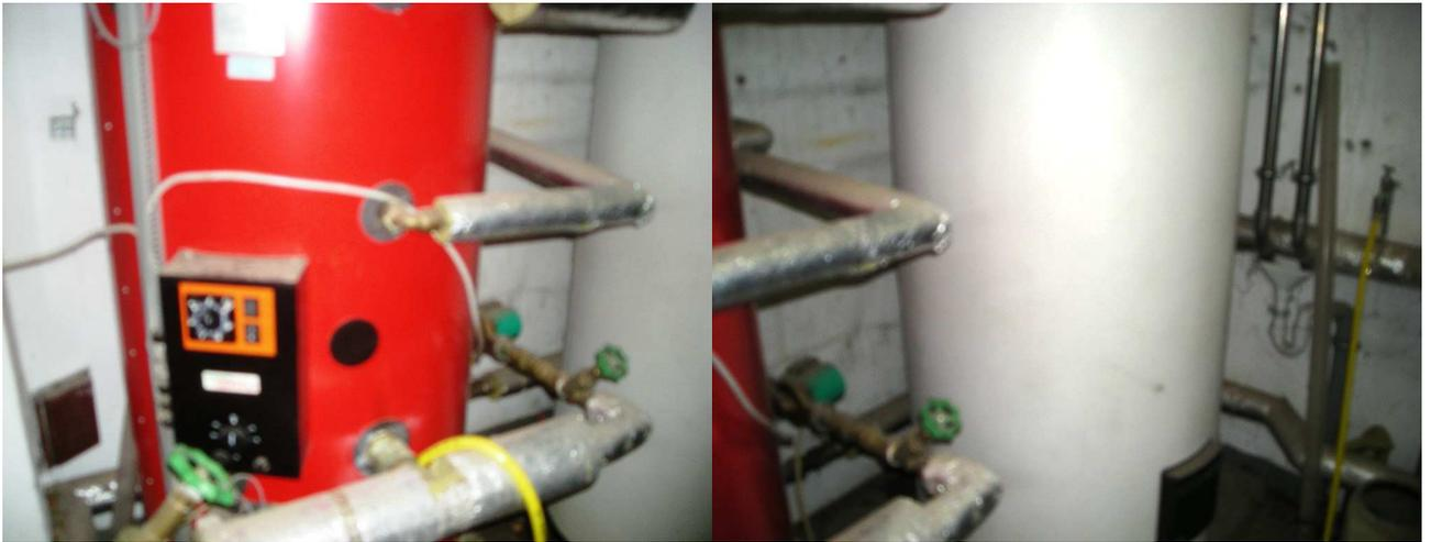
Direktbefeuerter Gas Warmwasser- und Pufferspeicher der Sportanlage
