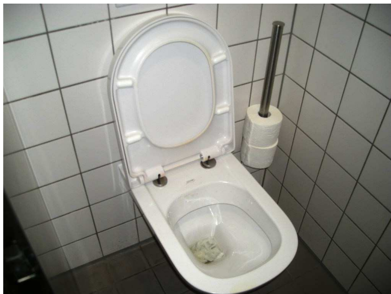
Toilette der Sportanlage
