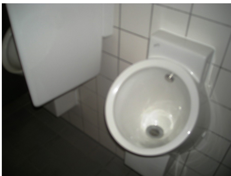
Urinal der Sportanlage
