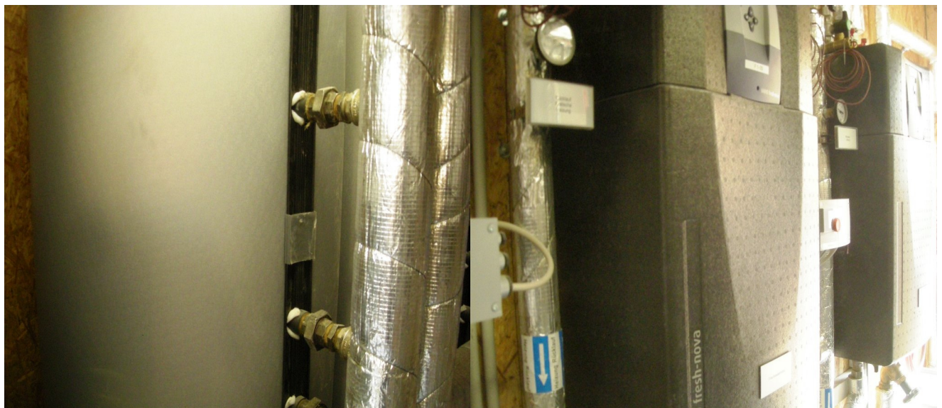
Pufferspeicher mit Frischwasserstationen des Umkleidegebäudes
