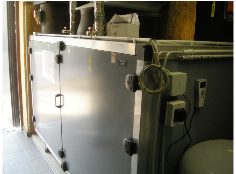
Lüftungsheizungsanlage des Umkleidegebäudes
