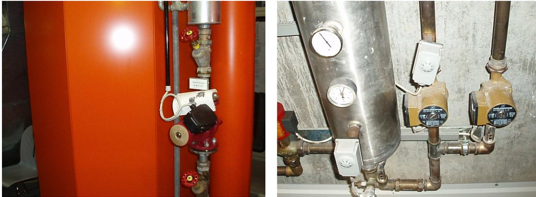
Die Zirkulationspumpen laufen über eine Zeitschaltuhr (ausgeschaltet 22-6 Uhr). Dämmung unvollständig, siehe Bild 11.
