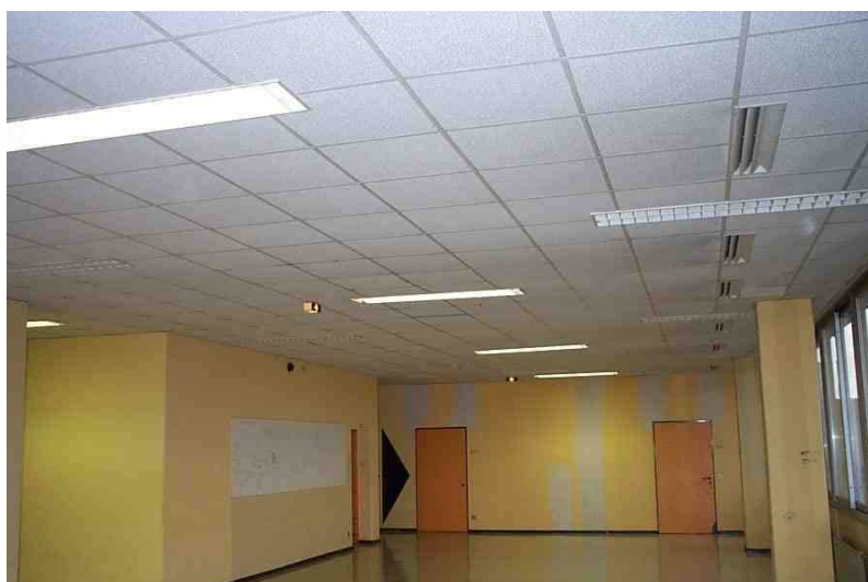
Bild 19 Standardleuchte ohne Lüftung im 4. OG
