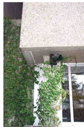
Bild 6, Bild 7 Wärmebrücken und ungedämmte Böden gegen außen
