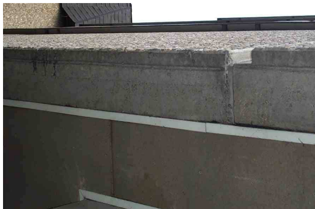
Bild 6, Bild 7 Wärmebrücken und ungedämmte Böden gegen außen
