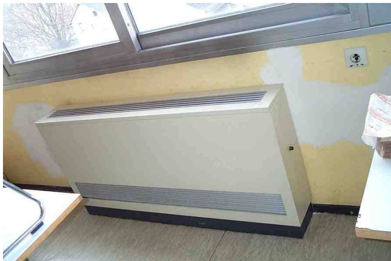
Bild 12 Brüstungsgerät für Zuluft und Heizung
