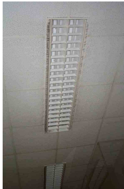
Bild 17 und Bild 18 Standardleuchten im Gebäude A/B in Flur (links) und Klassenräumen (rechts) mit und ohne Lüftung
