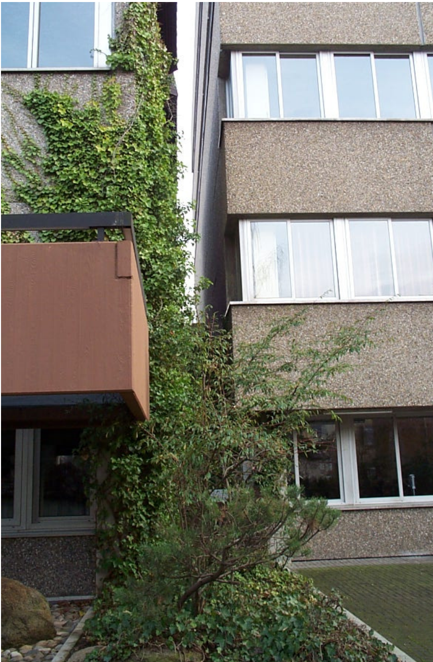
Luftspalt zwischen Bauteil B und C
