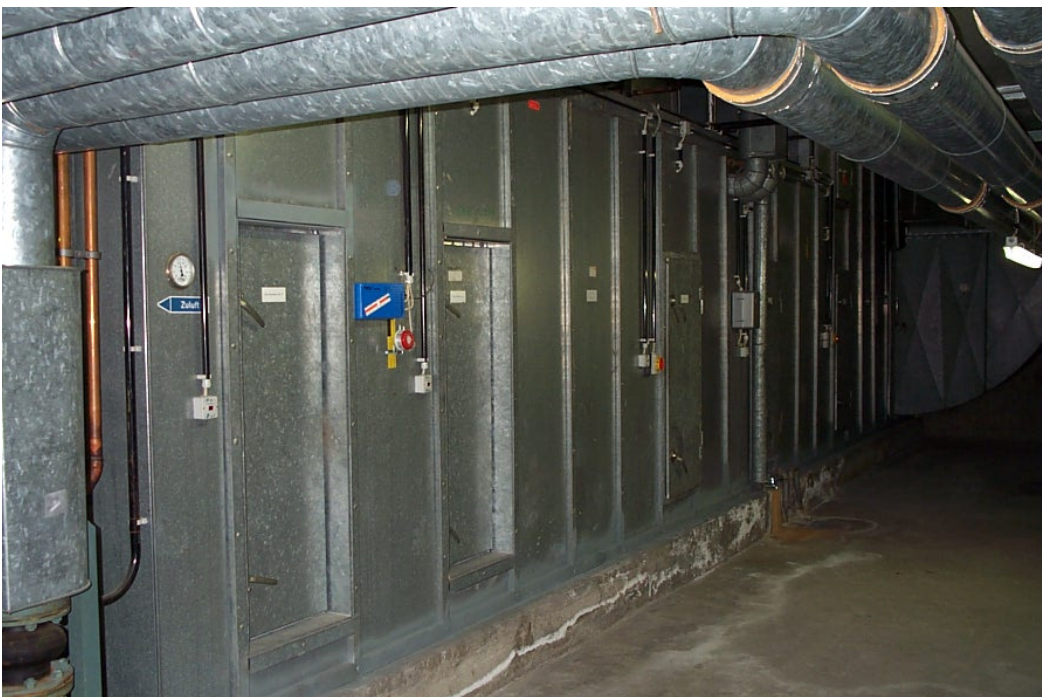
Zentrale Lüftungsanlage
