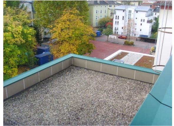
Flachdachflächen bekiest od. mit Waschbetonplatten, aufgesetztes Technikgeschoss
