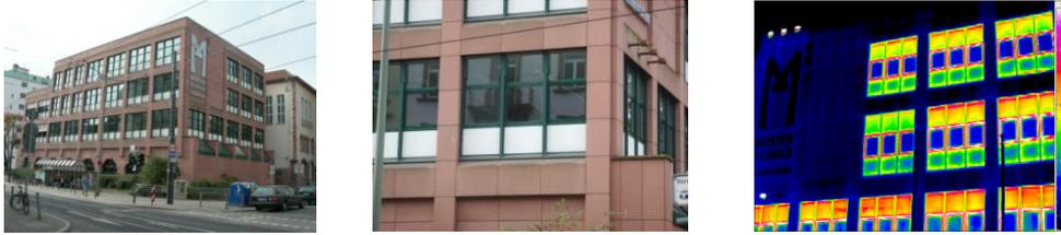
Fensterelemente Anbau-2 m. Thermographie Fassade
