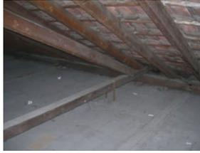
Ungedämmte Oberste Geschoßdecke , Bereich Altbau - Mittelbau
