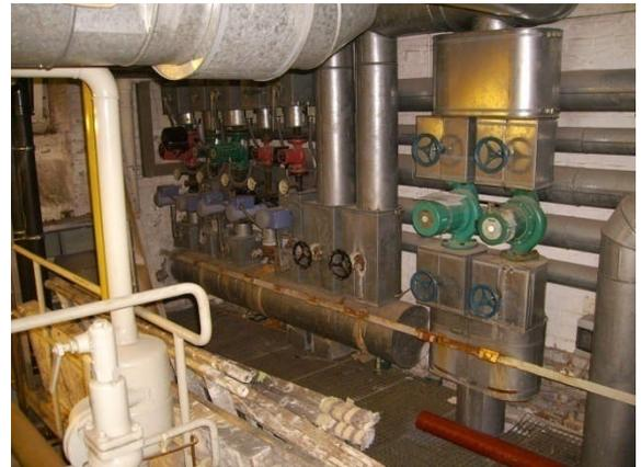
Gas-Heizkessel und Verteiler in Heizungsraum
