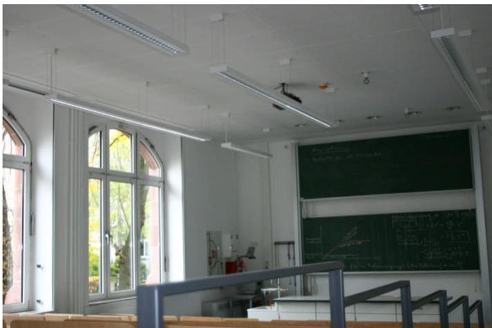
Altbau, elektr. sanierter Fachraum, Lehrsaal Physik mit abgependelten Rasterleuchten und Tafelbeleuchtung
