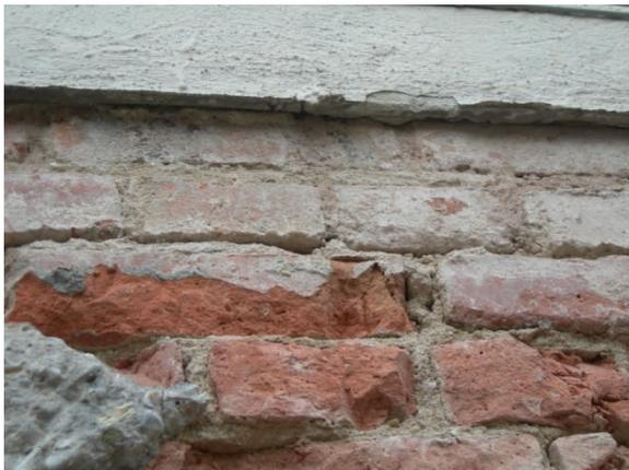
Außenwand/Altbau, freigelegter Sockelbereich, Mauerwerk mit Vollziegel
