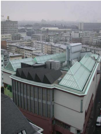
Beheizte Glasaufbauten auf dem Dach für indirekte Beleuchtung der obersten Ausstellungsebene.
