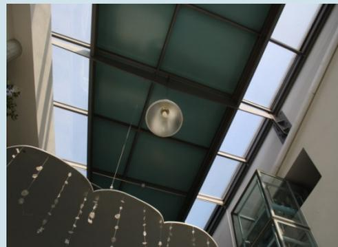
Durch den Glasanteil im Dach besteht ein erhöhtes Risiko einer Wärmebrücke.
