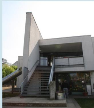
An der Nord-West-Seite des Gebäudes sind viele Kanten in der Außenwand vorhanden, deren inneren Flächen einer größeren äußeren Abkühlfläche gegenübersteht. Daher geht mehr Wärme verloren.
