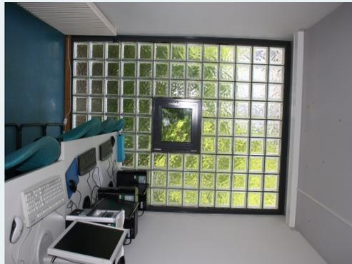
Energetisch unvorteilhaft sind die Glasbausteine in der Außenwand im 1.OG (Nord-Ost-Seite). Diese sollen im Rahmen der Sanierung mit Fenstern ersetzt werden.
