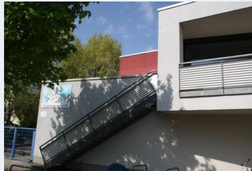
An dieser Stelle (Süd-Ost-Seite) sind viele Gebäudeecken vorhanden. Mittels einer guten Wärmedämmung kann der erhöhte Wärmestrom deutlich reduziert werden.
