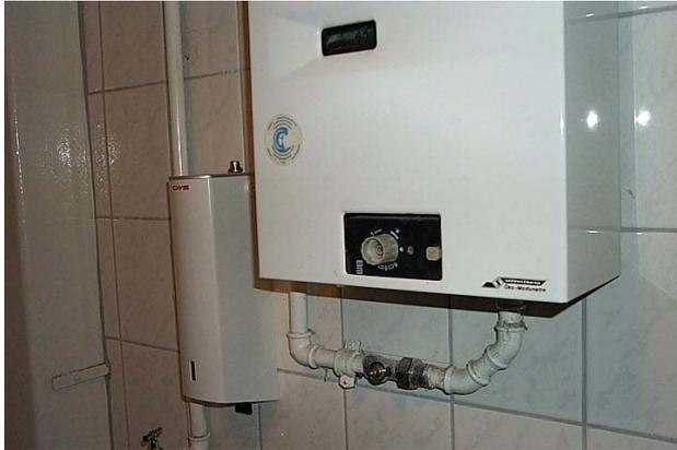
Die Temperatureinstellung des Gasheizgerätes ist für die Nutzer der öffentlichen Toilettenanlage frei zugänglich. Durch Betätigung des Drehknopfes kam es bereits mehrmals zur unnötigen Aufheizung der Toilettenanlage.
