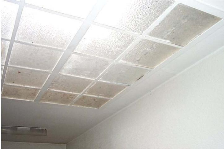
Die Wärmedurchgangskoeffizienten der Glasbausteine sind jedoch relativ ungünstig, so dass erhöhte Heizwärmeverluste auftreten.
