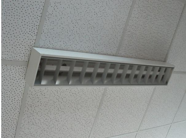
In den Sanitärbereichen sind überwiegend Leuchten mit 1 x 58 W Leuchtstofflampen installiert. Die installierte Leistung liegt hier bei rund 13 W/m<sup>2</sup>.
