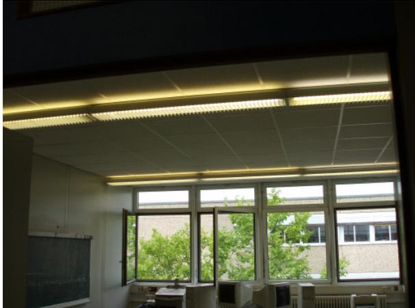
Da kein Deckenspiegel vorlag, wurden alle Leuchten neu erfasst und in beiliegendem Raumplan aufgenommen. In den Räumen ist überwiegend eine Leuchtenleistung von 20 bis 25 W/m<sup>2</sup> installiert. Einige wenige Räume haben einflammige Leuchten neueren Baujahres. Mit rund 20 -25 W/m<sup>2</sup> liegt die installierte Leistung weit über den heutigen Richtwerten, die bei 300 lx rund 7,5 W/m<sup>2</sup> vorsehen
