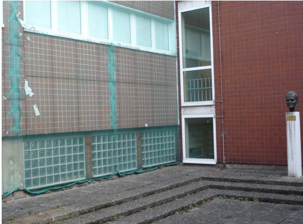
Auffällig ist die wärmetechnisch schlechte Qualität der Glasbausteine und die „Zwangs“- Entlüftungsöffnungen darüber.
