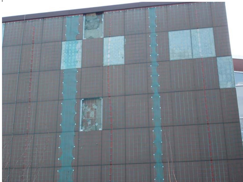
Die Bereiche ohne Kacheln haben andere Oberflächeneigenschaften und sind deshalb in der Thermografie sichtbar. An den Bereichen mit abmontierten Fassadenplatten wurde teilweise auch die Wärmedämmung entfernt.
