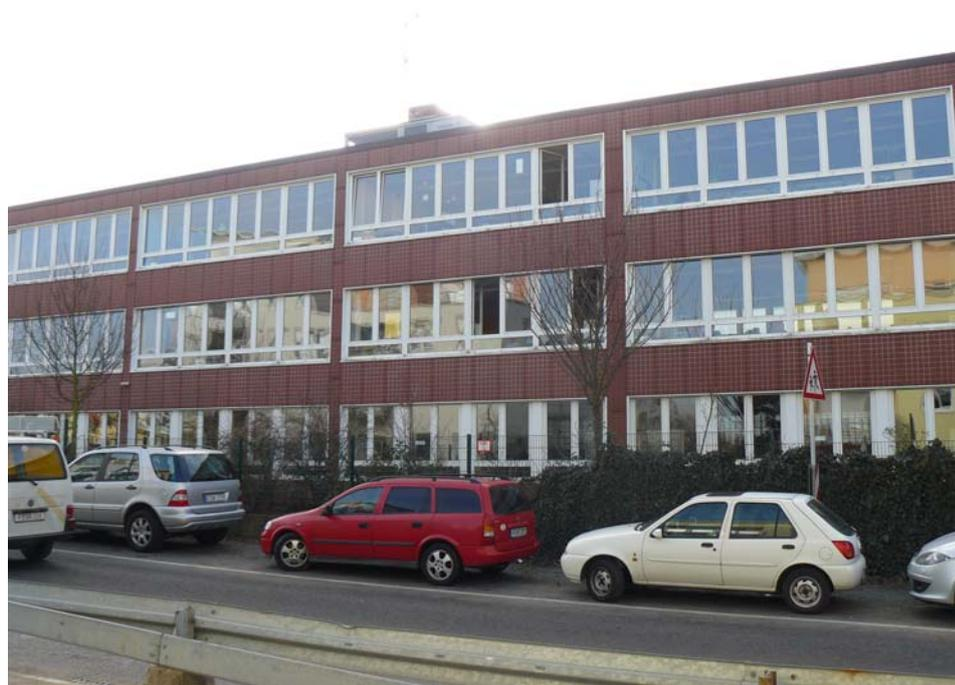
Auffallend sind natürlich die zur Lüftung geöffneten Fenster. Der Überbau auf dem Dach scheint (vermutlich unnötigerweise) ebenfalls beheizt zu werden. Dies sollte im Zuge der Sanierung geprüft werden.
