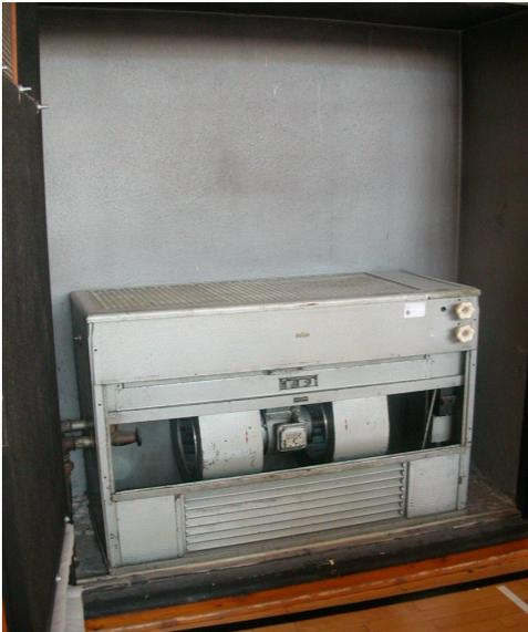
**Abb. 3.10 Lüftungsgerät Turnhalle**
