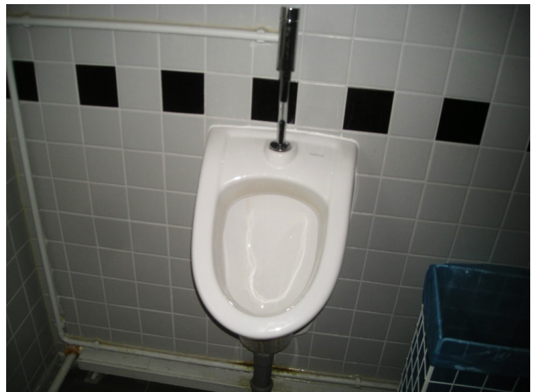
Urinal des Betriebshofes
