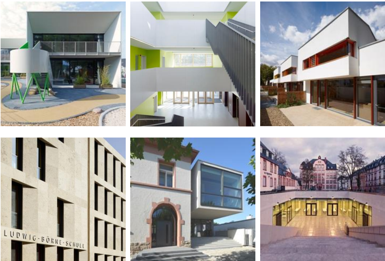
Abbildung 1: Passivhaus-Neubauprojekte der Stadt Frankfurt a.M. (KT Eulenberg, Ziehenschule, KT Griesheim, Ludwig-Börne-Schule, Grundschule Kalbach, IGS Nordend)
