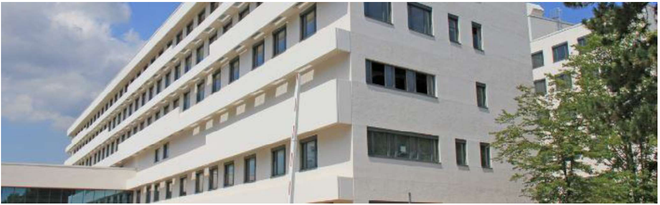
Der Neubau des varisano Klinikums Frankfurt Höchst ist erfolgreich im Passivhaus-Standard realisiert worden. Über 1600 Beschäftigte werden im neuen Gebäude tätig sein. © Klinikum Frankfurt Höchst
