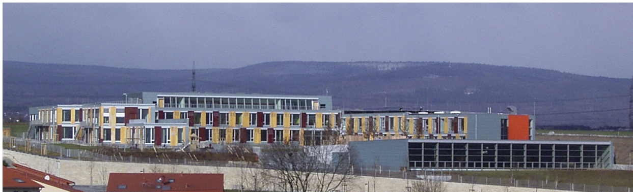
Ansicht der Schule von Südost
