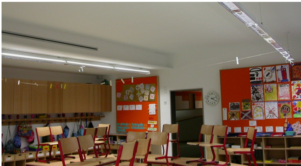
Klassenraum mit abgehängter Decke, Akustik-Pinnwand, Weitwurfschlitz (Zuluft), Zertifikate
