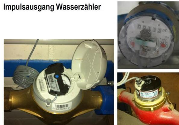
*Bild 4: Stromzähler, Gaszähler, Wärmehzähler und Wasserzähler mit Impulsausgängen
