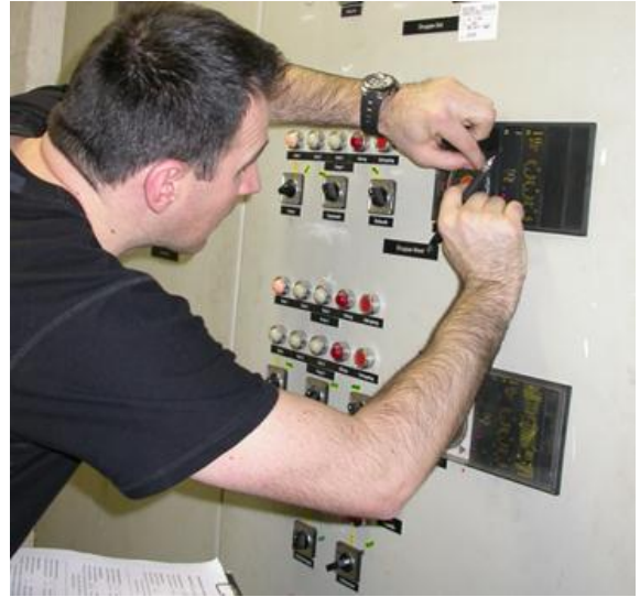
Beispiel Linnéschule: durch die Betriebsoptimierung geschulter Schulhausverwalter bei der Einstellung der Heizungsregelung
