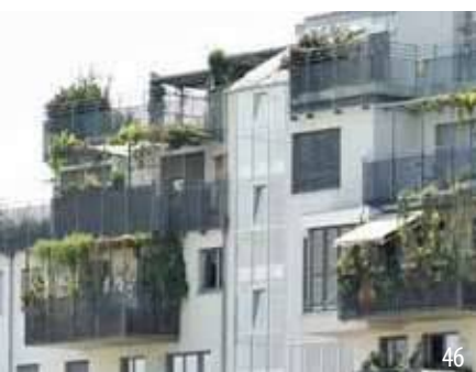
46 Helle Fassaden- und Dachflächen sowie Gebäudebegrünung
