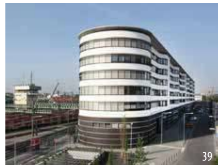
Zertifiziertes Gebäude des Grünflächenamtes
