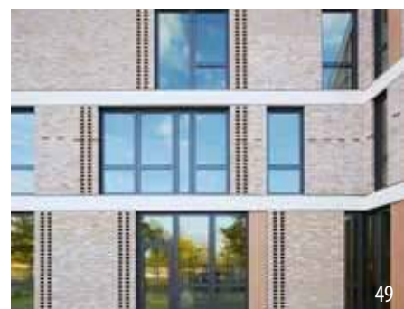
Passivhausbau im Schulbereich
