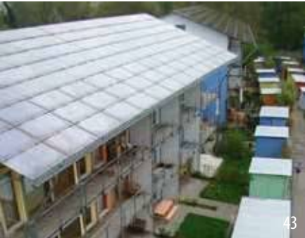
43 Solarsiedlung Freiburg mit integrierten Photovoltaikanlagen auf den Dächern
